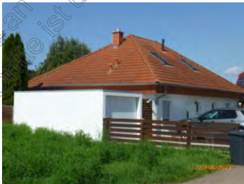
Ansicht von Süd-Osten
