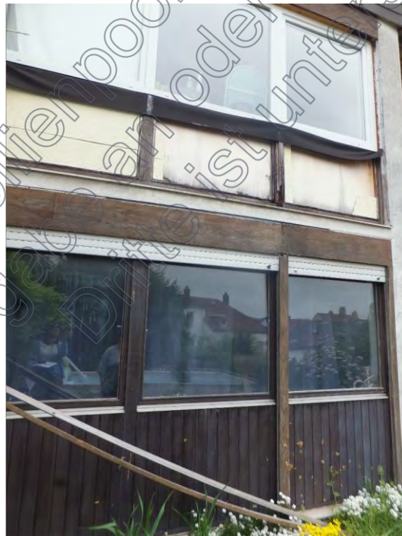
Bild 6: Fehlende Fassadenbekleidung
