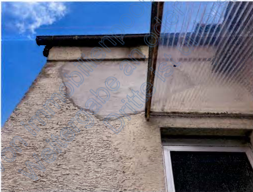
Detail Fassade Nordseite; Putzausbesserungen
