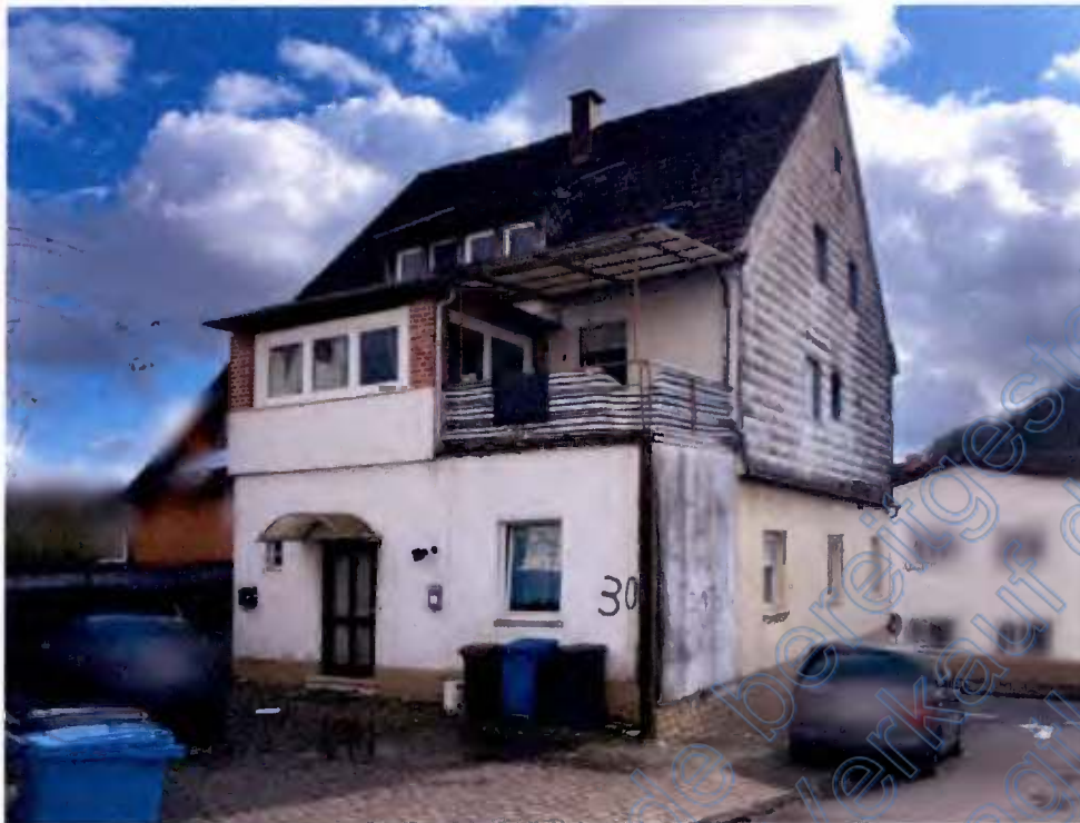
Nordwest-Ecke; Kloostergasse; Anbau und Hoffläche; Zugang Wohnung Erdgeschoss
