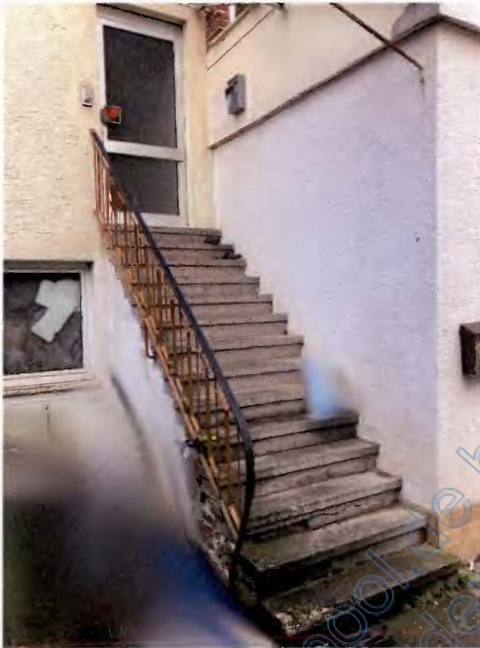
Außentreppe Zugang zur Maisonette-Wohnung OG/DG
