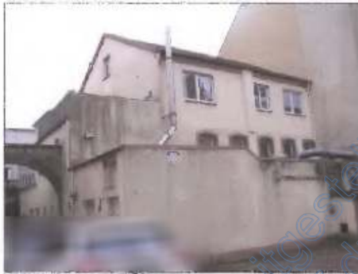
Rückansicht von der Rosengartenstraße
