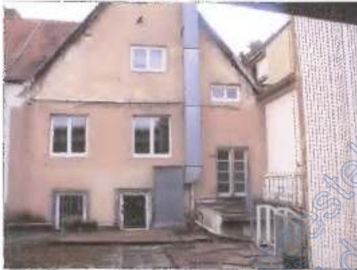
Rückansicht vom Flachdach des Anbaus auf Gebäudeteil 1 (Denkmal)
