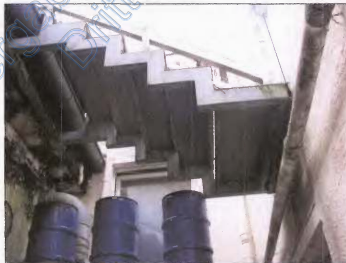
Außentreppe vom Wintergarten zum Flachdach
