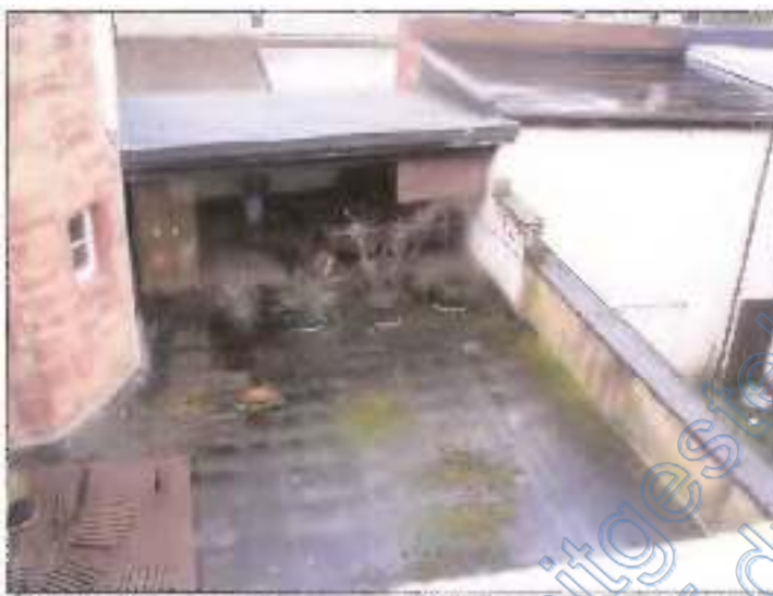
überdachter Freisitz auf Flachdach
