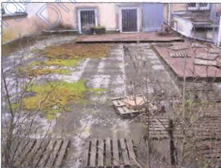
Flachdach über Anbau Gaststätte – Sicht vom überdachten Freisitz
