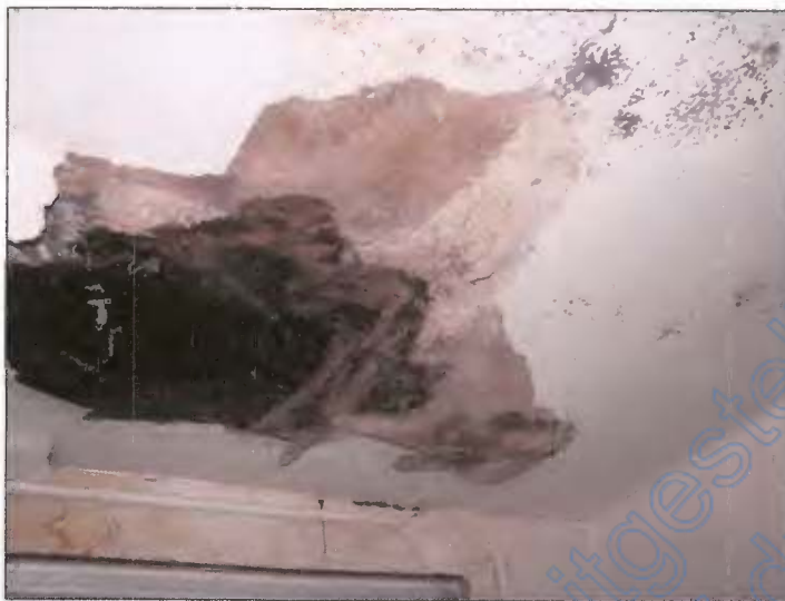
Deckenansicht Erdgeschoss zum Flachdach
