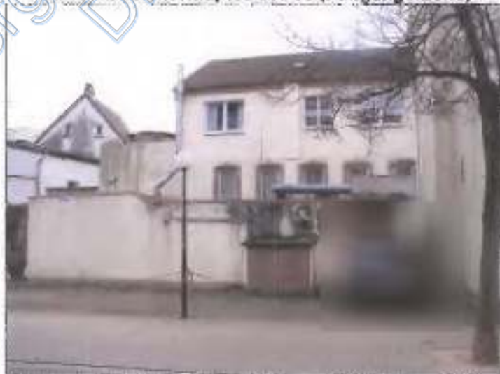
Rückansicht mit Stellplätzen von der Rosengartenstraße
