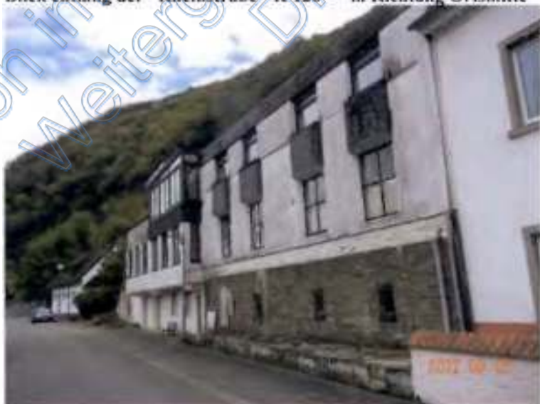
Straßenansicht des Werkstatt- und Wohngebäudes
