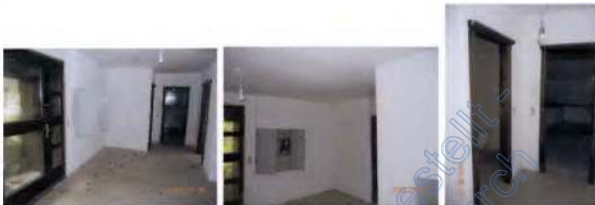
Wohnungseigentum / DG: Flurbereich hinter der Wohnungseingangstür zur Hauptwohnung
