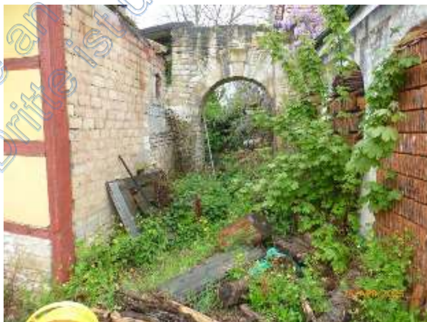
Grundstückszugang von Süden
