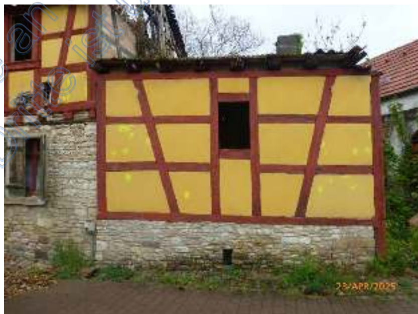
Ansicht von Süden, Anbau
