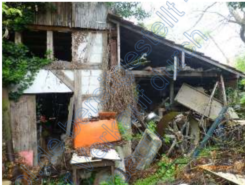
Ansicht von Süden, Scheune
