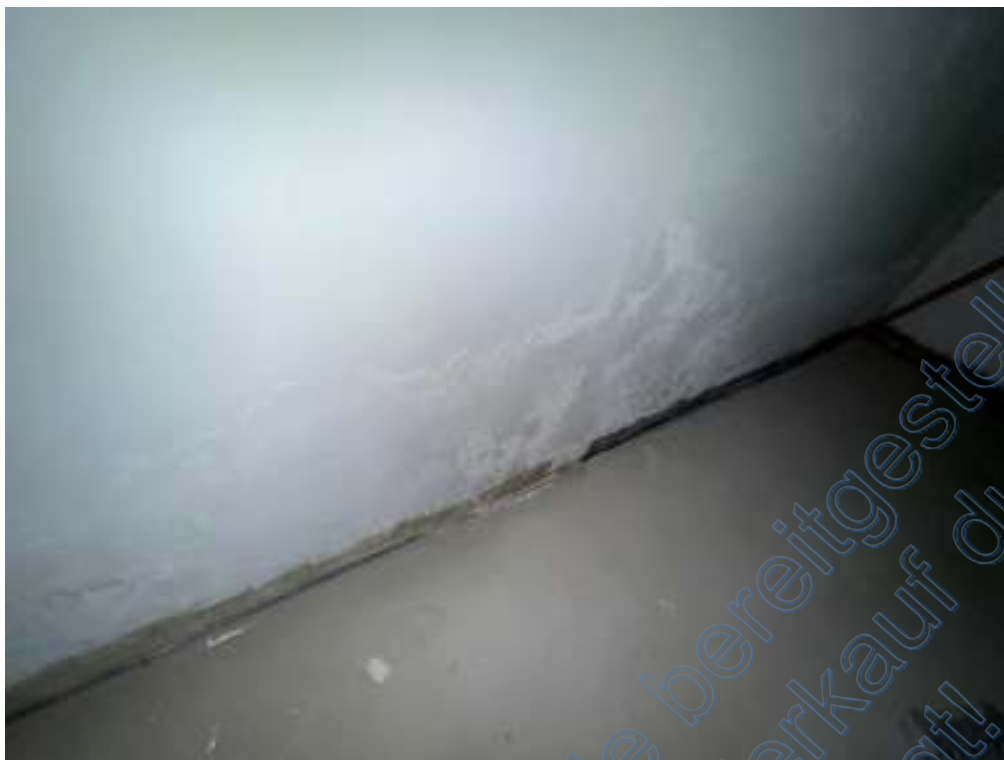
Feuchtespuren in KG
