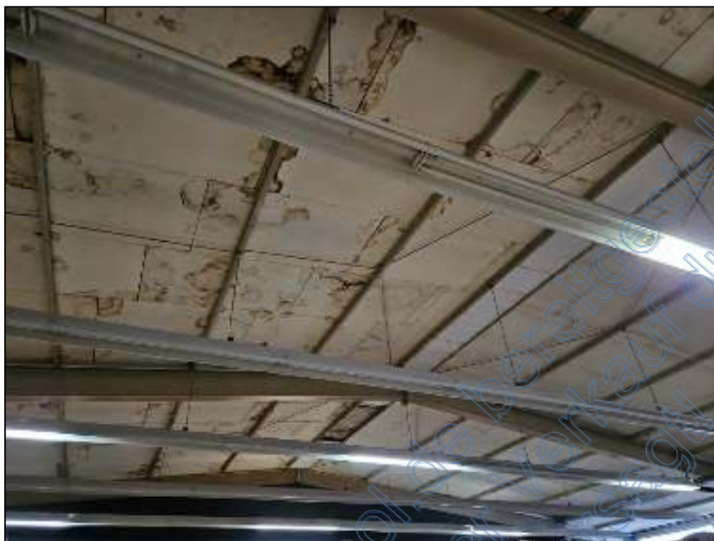
Deckenunterseite südliche Hallen
