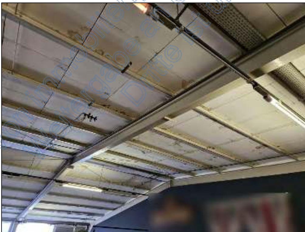
Deckenunterseite südliche Hallen
