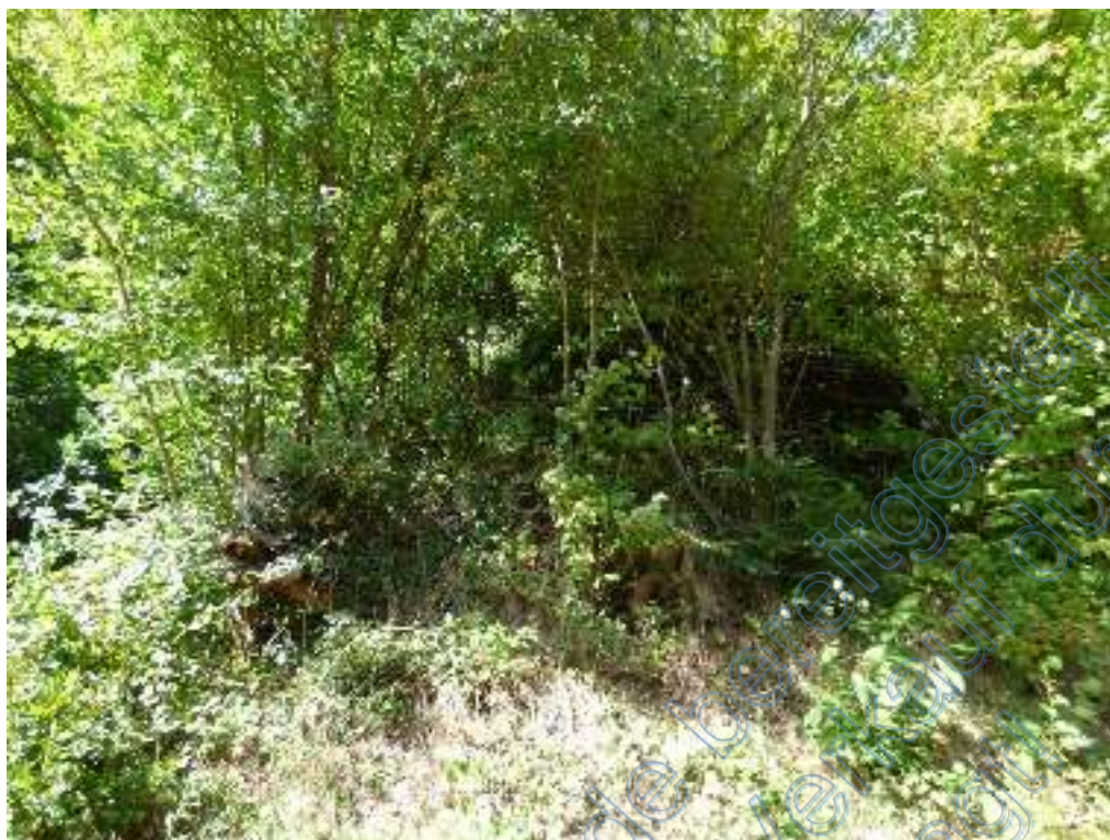
Bild 5: Böschung im Bereich Punkt 2
