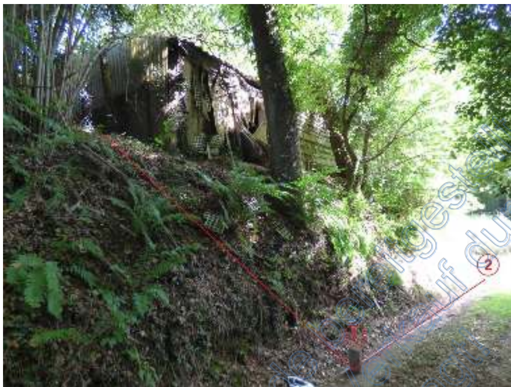
Bild 3: Grundstücksgrenze im Bereich der Punkten 1 & 2; vorhandene „Schuppen“
