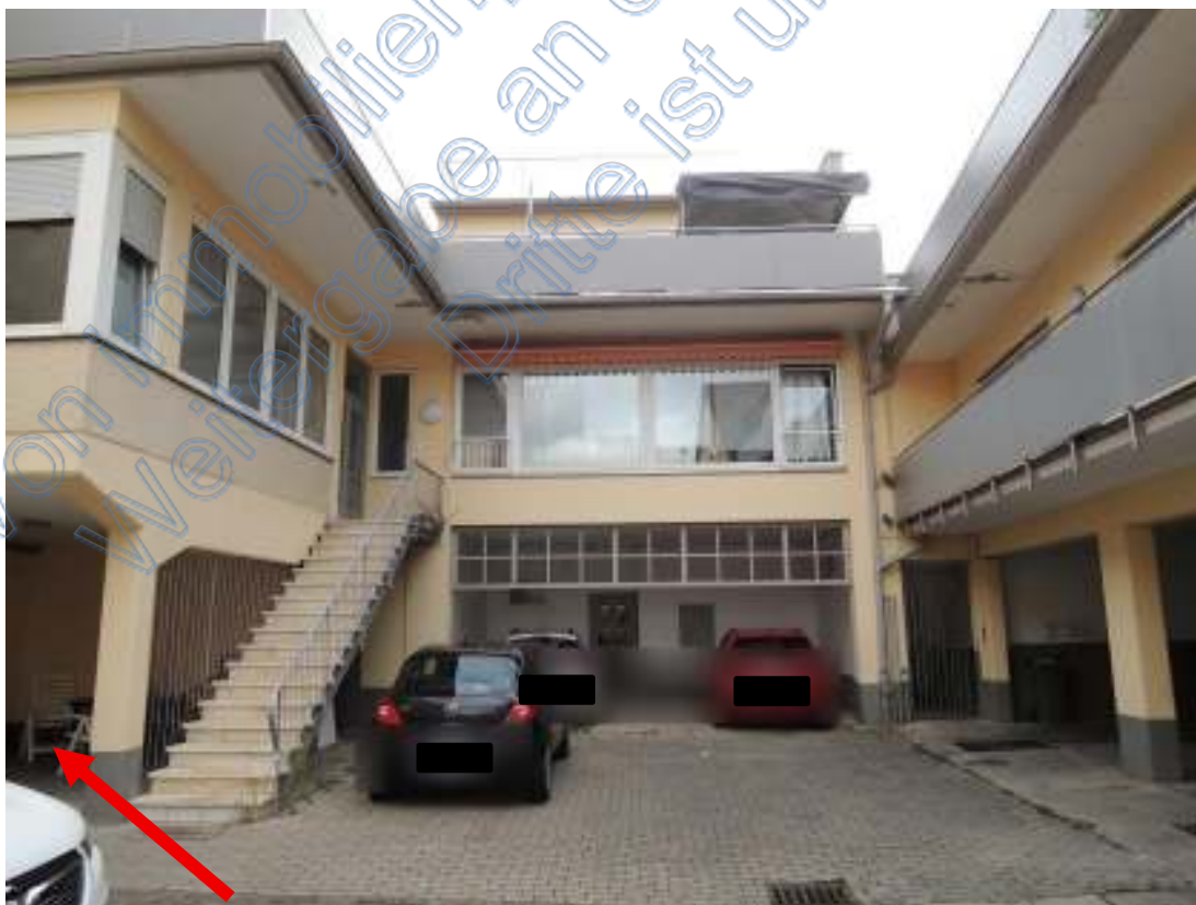
Zugang zur Wohneinheit (siehe Pfeil)
