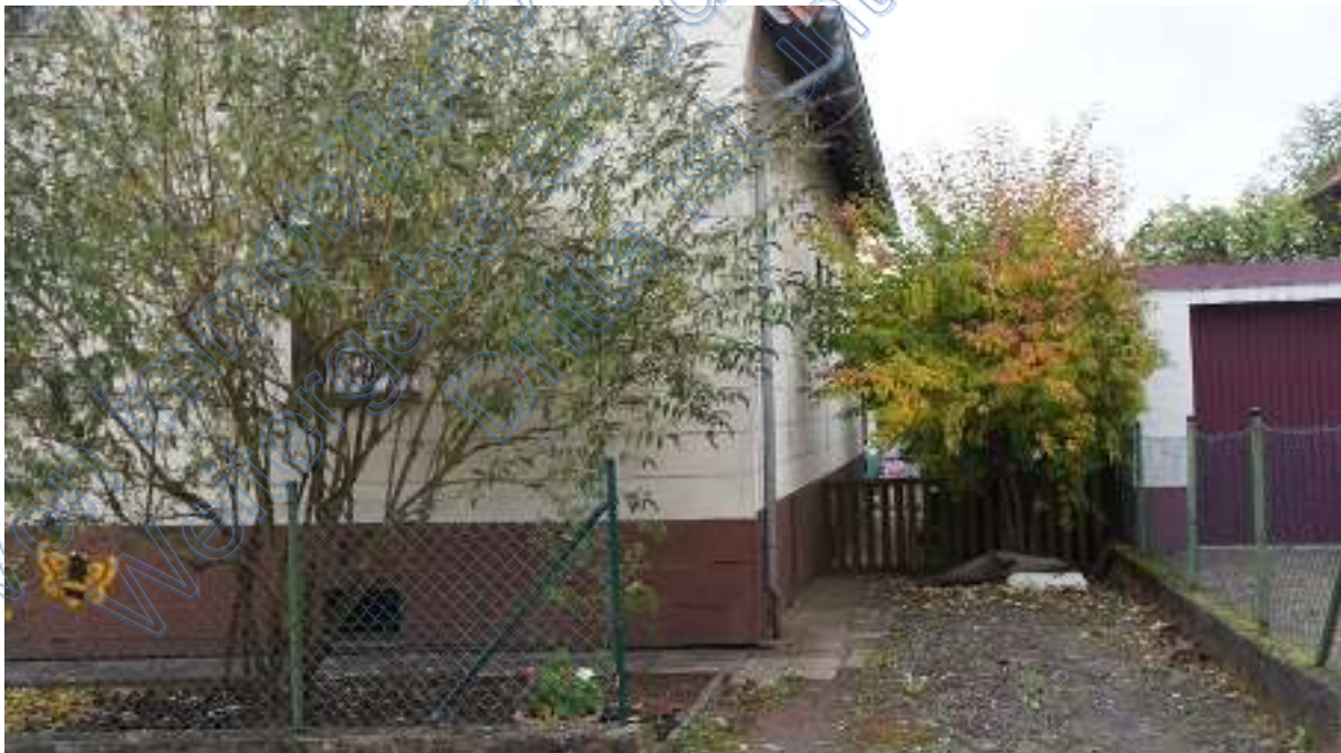
Außenansicht Einfamilienhaus, Ostseite
