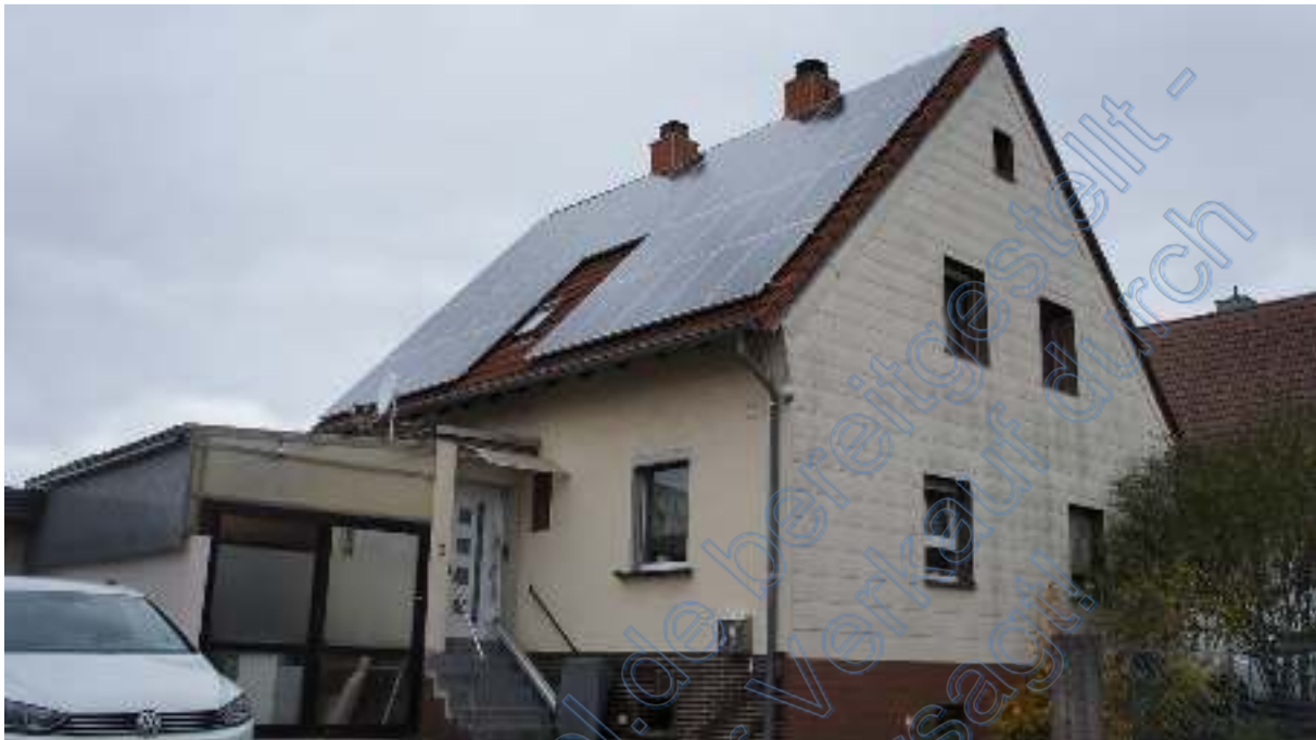
Außenansicht Ostseite mit Photovoltaikanlage
