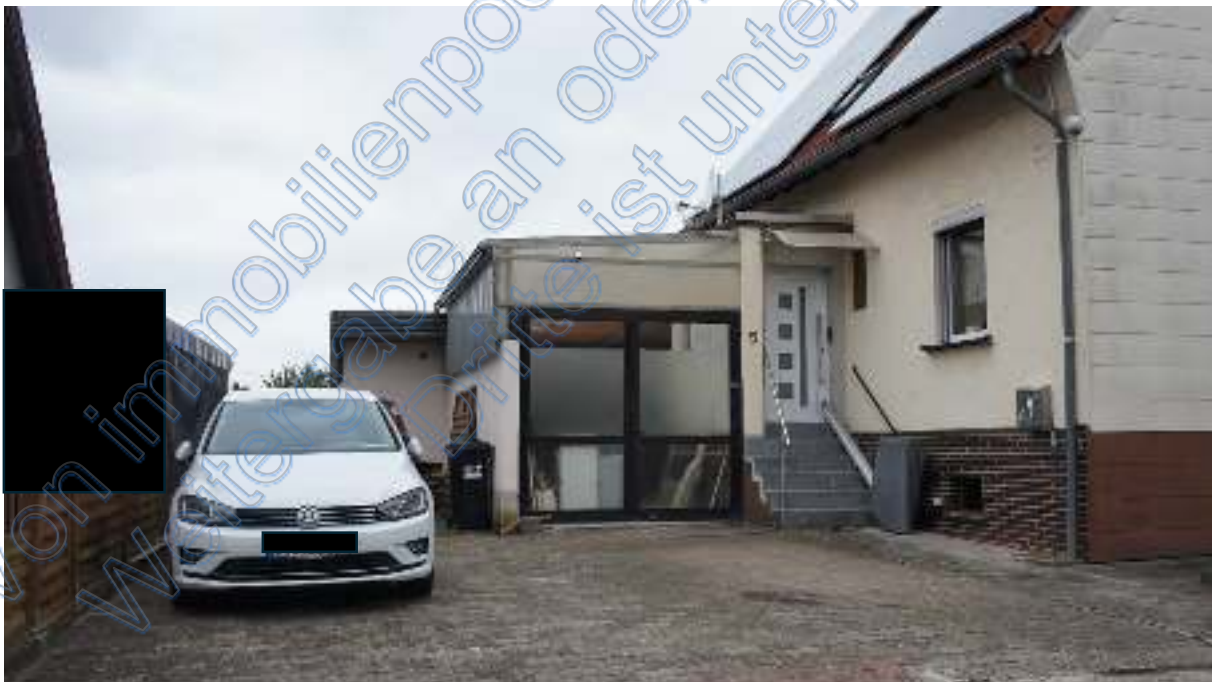
Außenansicht Ostseite mit Photovoltaikanlage
