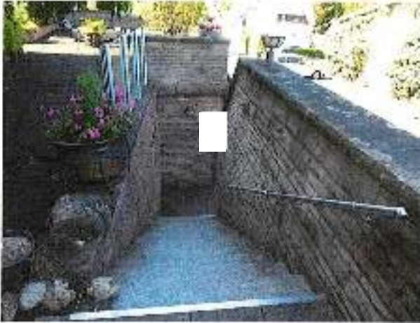
Treppe von Straßenniveau auf Zwischenniveau
