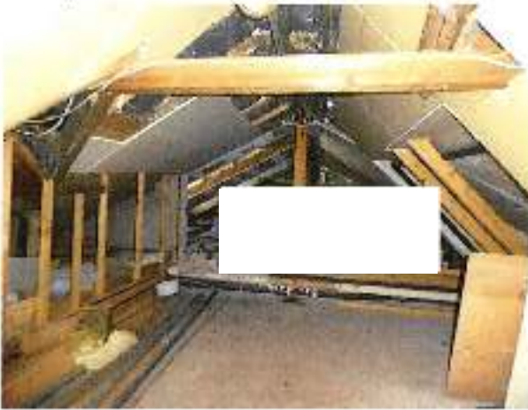
Spitzboden, Zugang aus DG-Einheit
