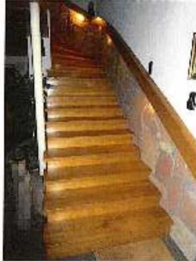
Zugangstreppe ins DG
