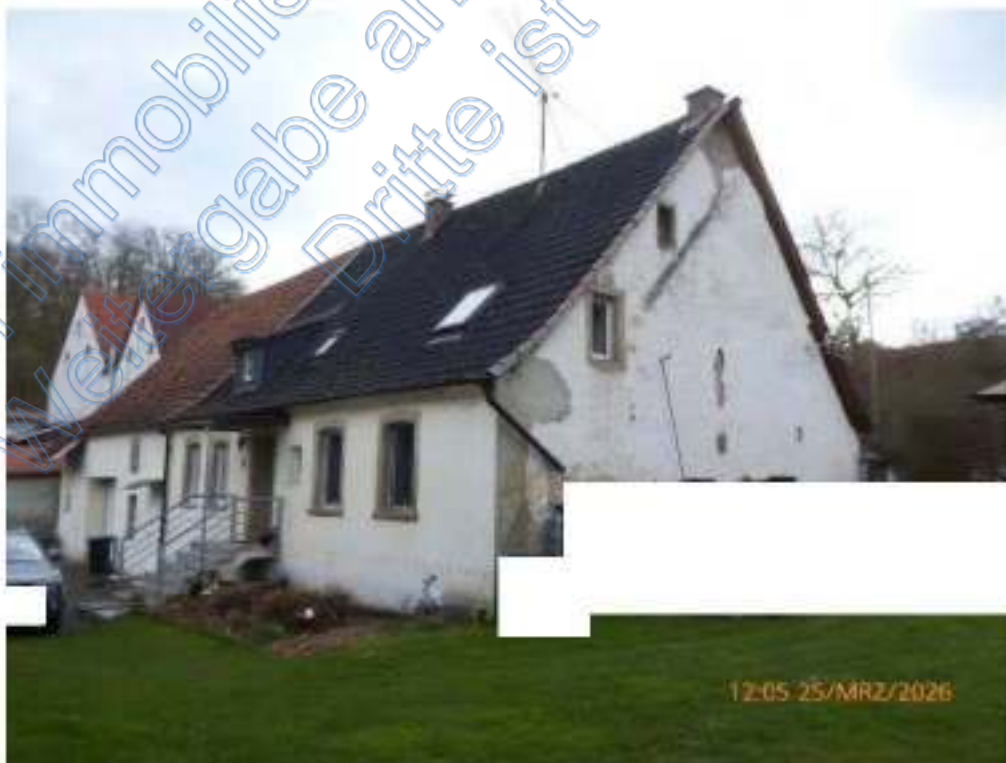
Foto 2 – Westansicht gesamtes Gebäude
