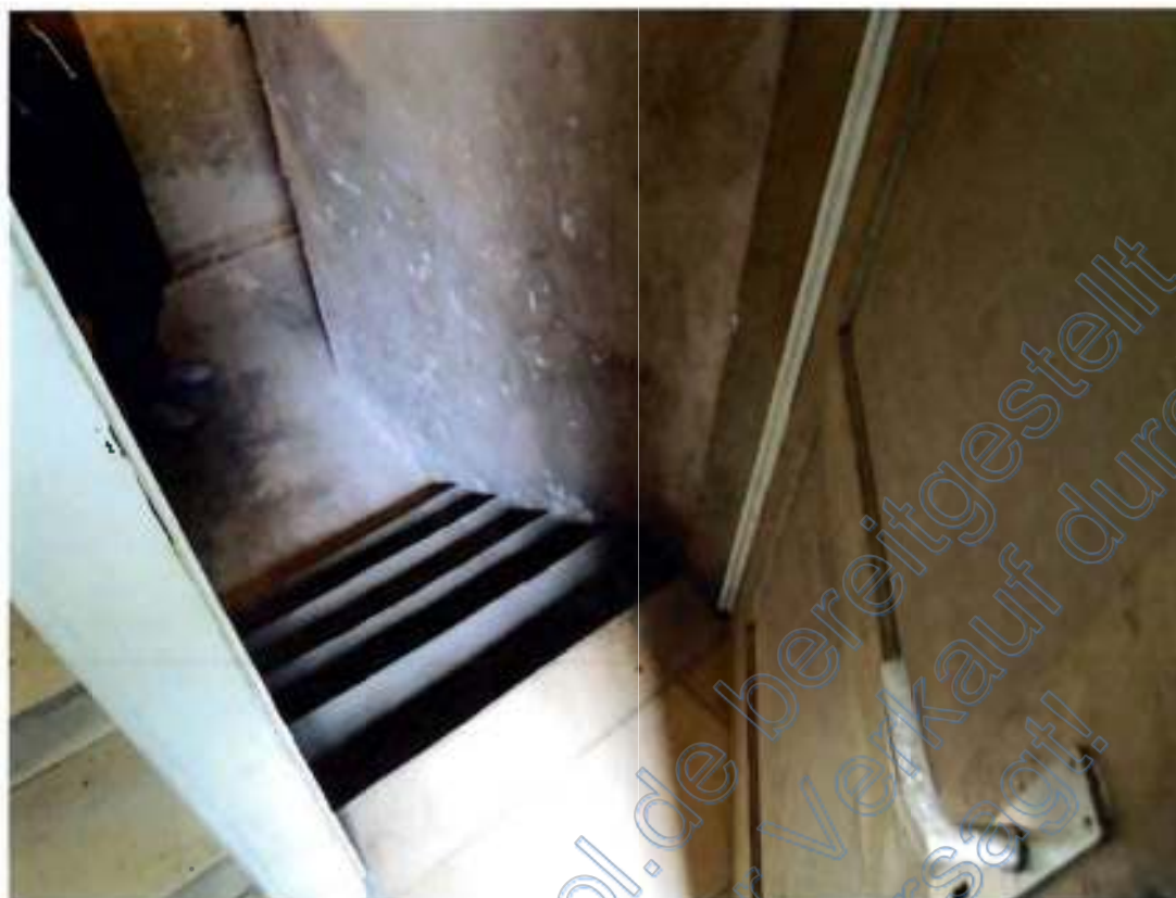
Treppenabgang zum Keller
