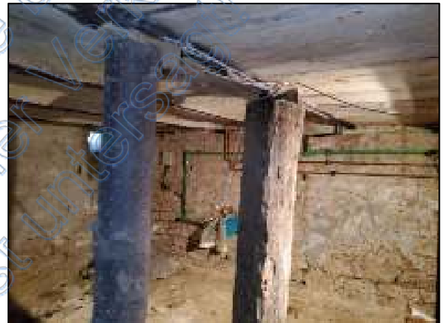
Bild 4: Kellerraum; abgestützte Decke
