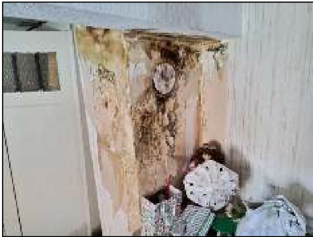
Bild 13: Detailbild Feuchtschaden Kamin OG
