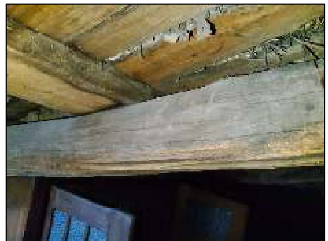
Bild 18: Detailbild Holzträger; Holzwurmbefall
