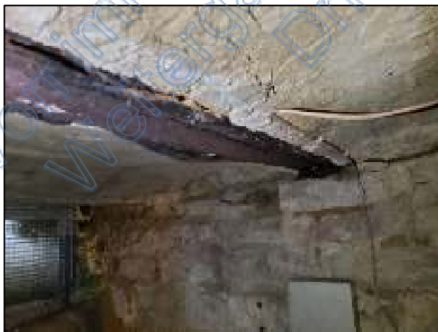
Bild 5: Detailbild korrodierter Eisenträger
