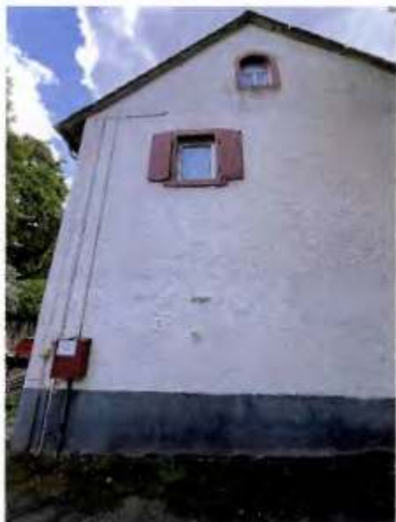
Abbildung 12: Seitenansicht des Wohnhauses 7B.
