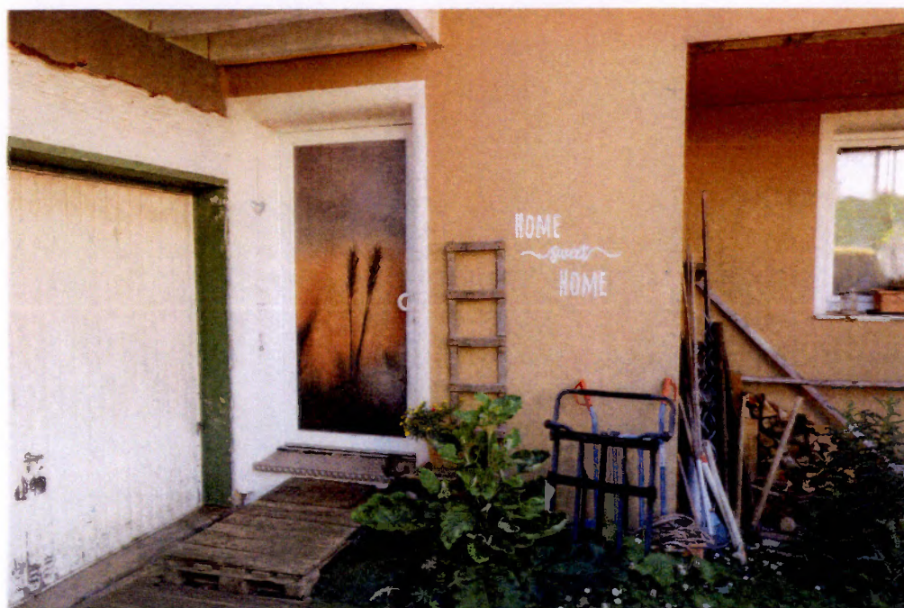
BILD 08 ANSICHT NORDWEST - ZUGANG MIT PROVISORISCHEN STUFEN /PODEST -
