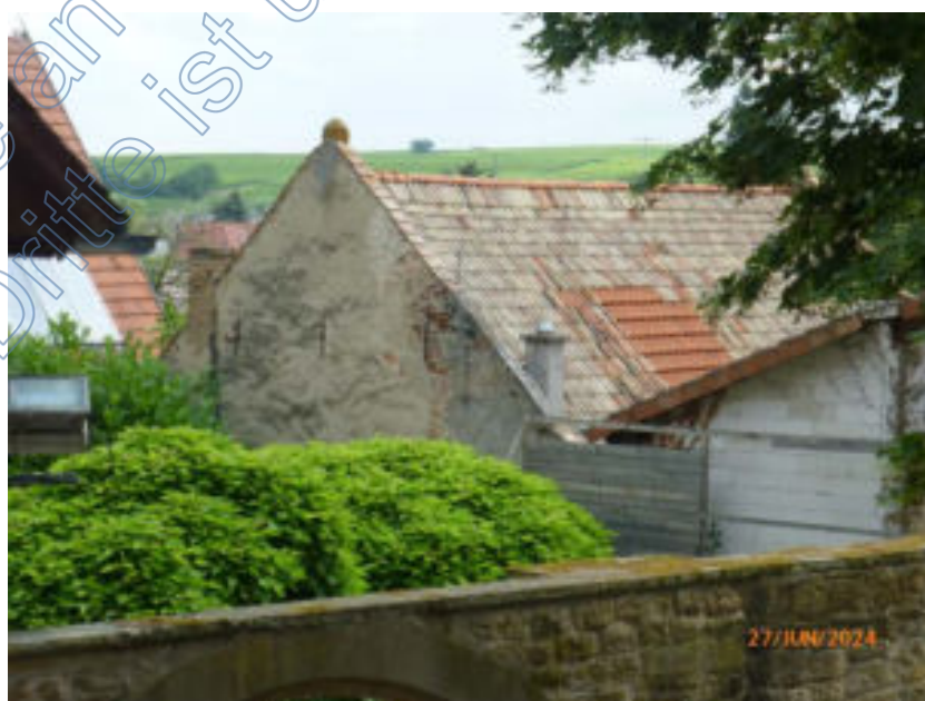
Scheune, Ansicht von Westen
