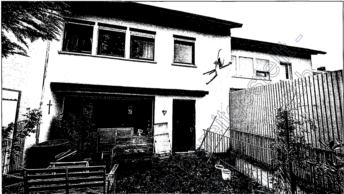
Bild B3: exemplarische Außenansicht Wohnhaus Flurstück 163/135
