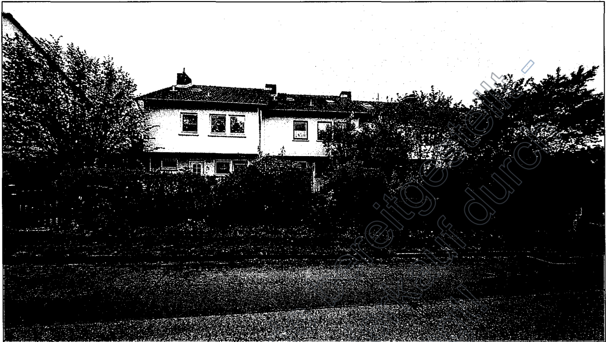
Bild B1: exemplarische Außenansicht Wohnhaus Flurstück 163/135
