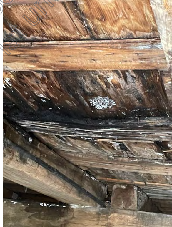
Zwischendecke Scheune, Pilzbefall, Holzfäulnis, Empfehlung: Abklärung Verdacht auf Hausschwamm
