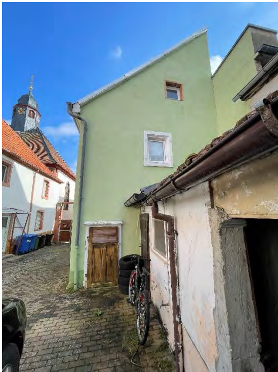
Eingang Keller und Anbau
