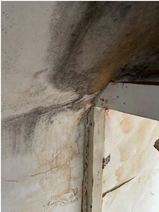
Feuchteschaden, Treppenraum DG
