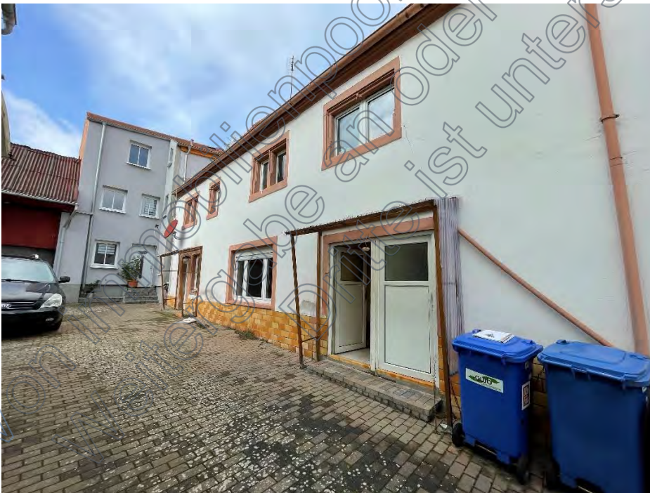
Eingangsbereich Neugasse 31, Hof (Flurstück-Nr. 99/5)
