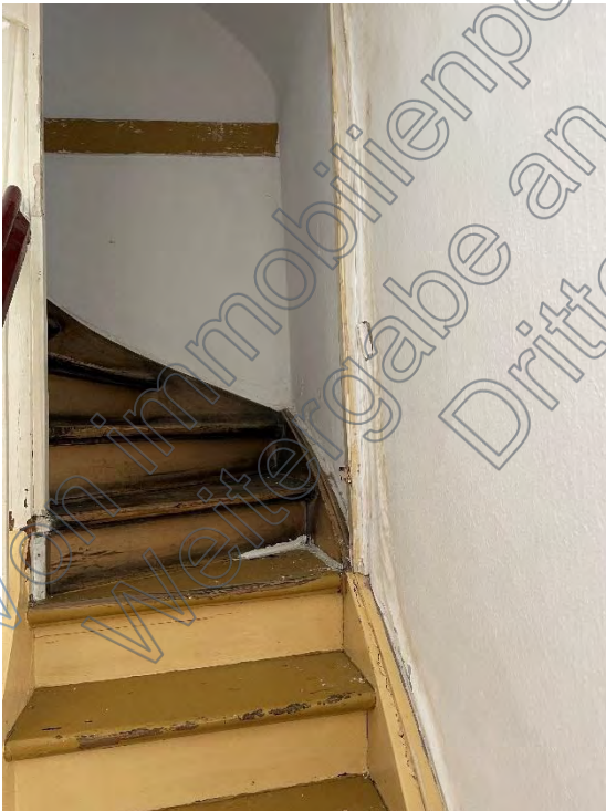
Treppe zum DG
