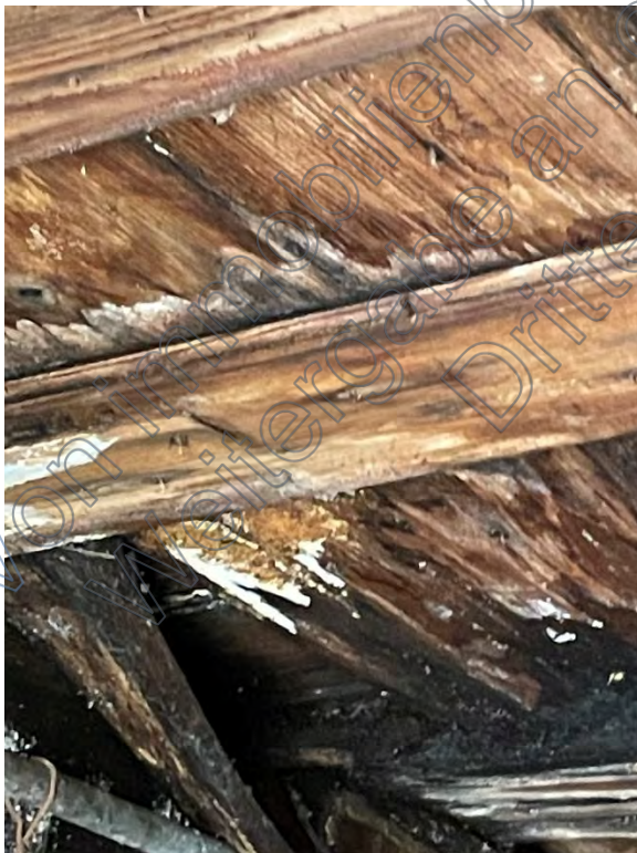
Zwischendecke Scheune, Pilzbefall, Holzfäulnis, Empfehlung: Abklärung Verdacht auf Hausschwamm
