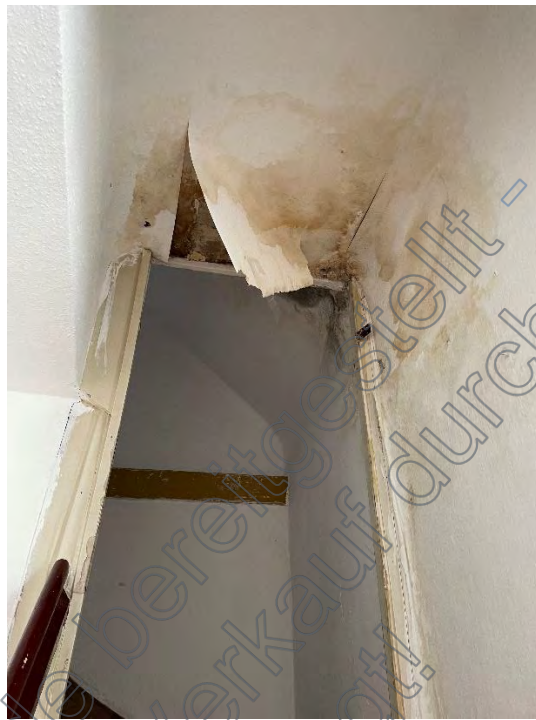
Feuchteschaden, Treppenraum DG
