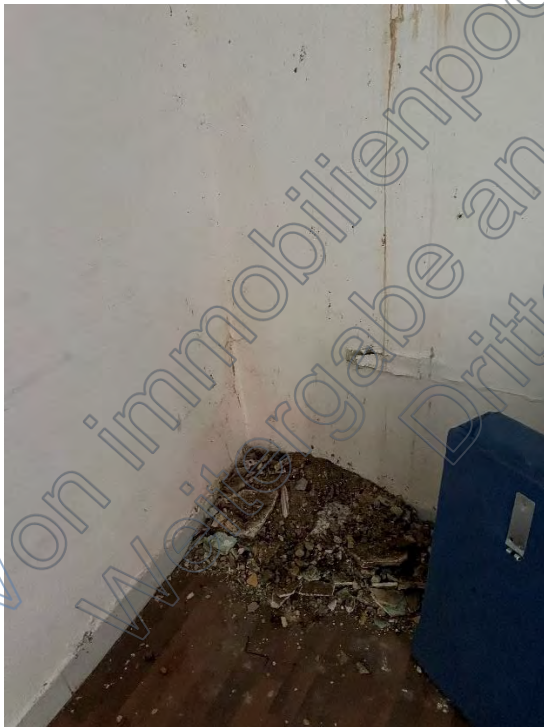
Deckeneinbruch (augenscheinlich Holzbalkendecke) EG-Wohnung im Nebenzimmer vermutlich durch Wasserschaden
