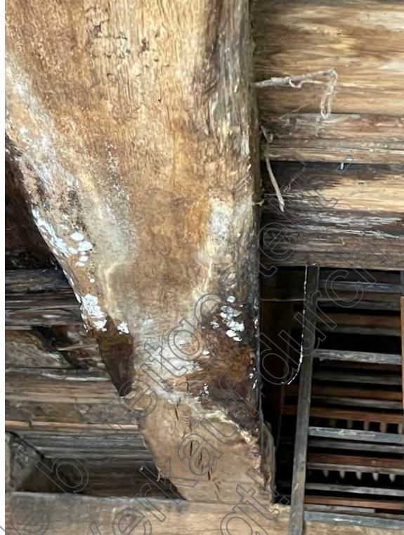
Zwischendecke Scheune, Pilzbefall, Holzfäulnis, Empfehlung: Abklärung Verdacht auf Hausschwamm
