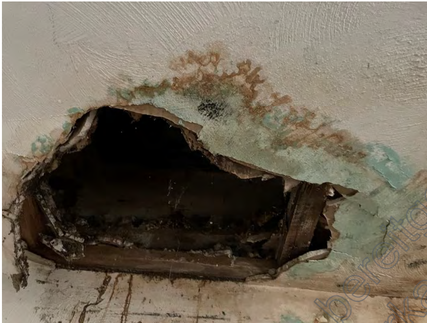
Deckeneinbruch (augenscheinlich Holzbalkendecke) EG-Wohnung im Nebenzimmer vermutlich durch Wasserschaden
