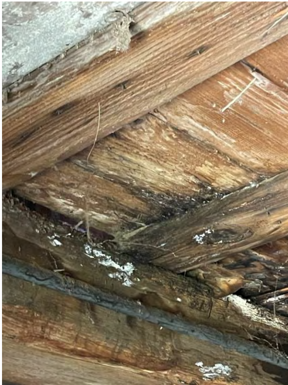
Zwischendecke Scheune, Pilzbefall, Holzfäulnis, Empfehlung: Abklärung Verdacht auf Hausschwamm
