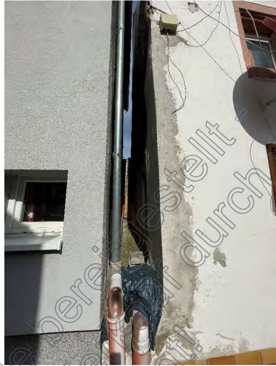
Grenzbereich zur Nachbarbebauung
