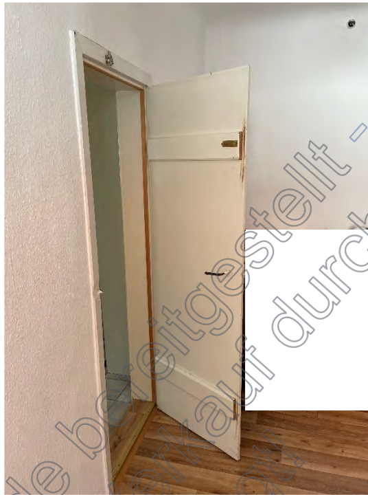
Tür Bad OG
