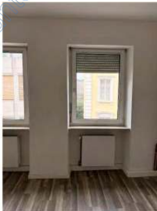
2-fach verglaste Kunststofffenster
