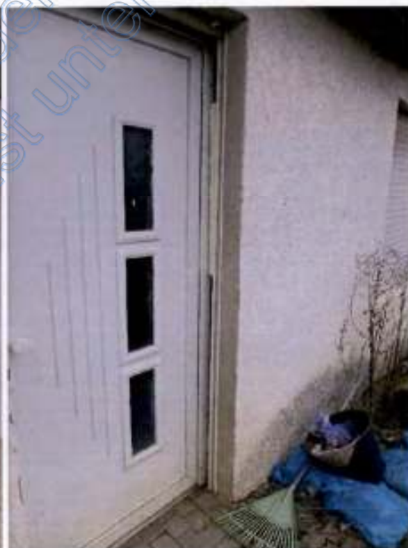
8 b Eingangstür Keller
