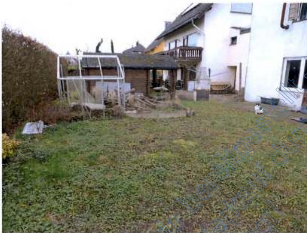
15 Garten, schadhaftes Gartenhaus
