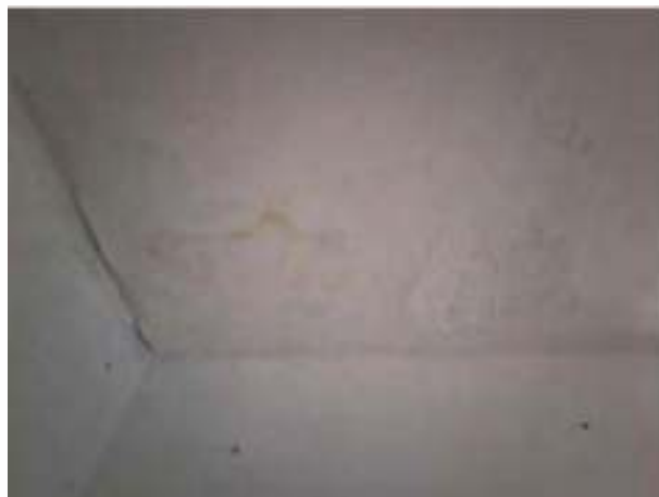
Bild 60 – Wasserschaden 2. OG
