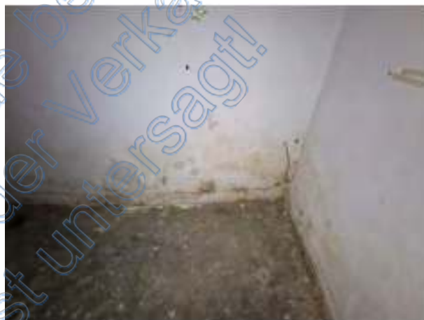
Bild 70 – Massive Feuchtigkeit
