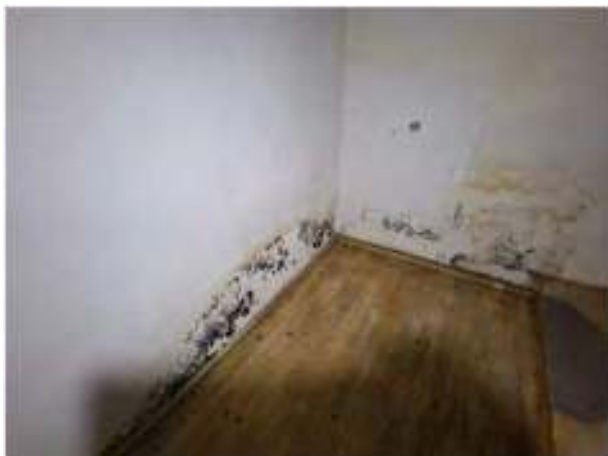
Bild 67 – Schimmelbefall (Anbau)
