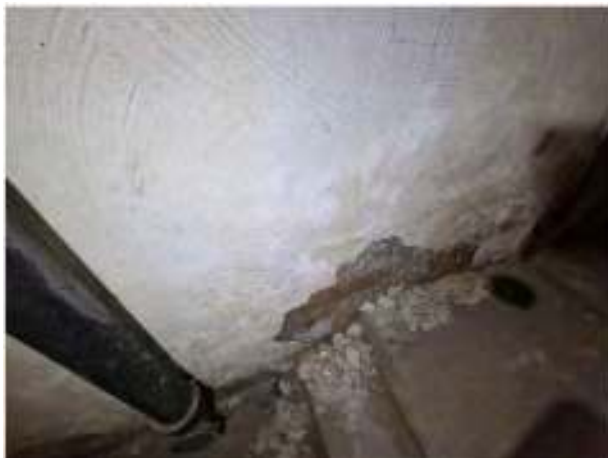
Bild 49 – Feuchtigkeitschaden
