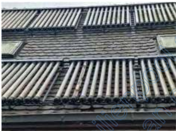
Bild 57 – Defekte Solarpanels
