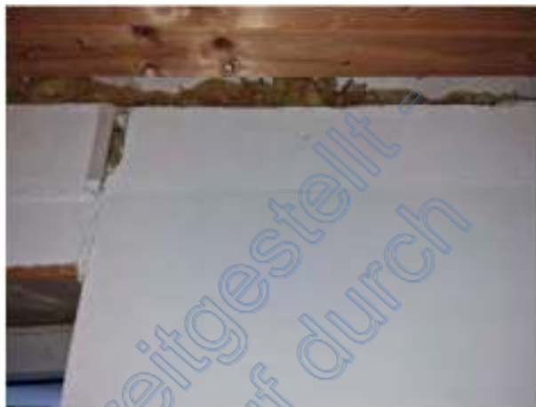
Bild 50 – Offenes Dämmmaterial
