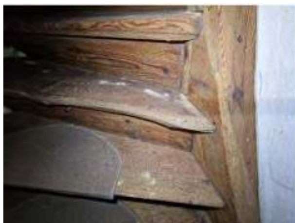
Bild 72 – Holzwurmbefall Treppenaufgang
