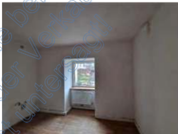
Bild 28 – Fenster und Heizung (DG)
