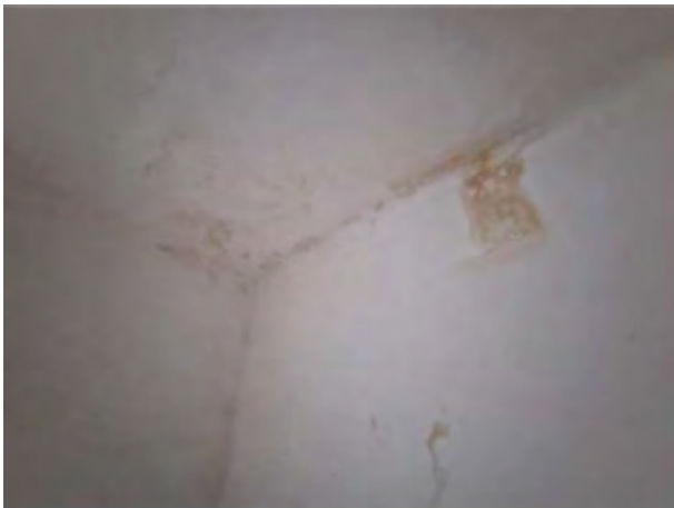
Bild 61 – Massive Feuchtigkeit
