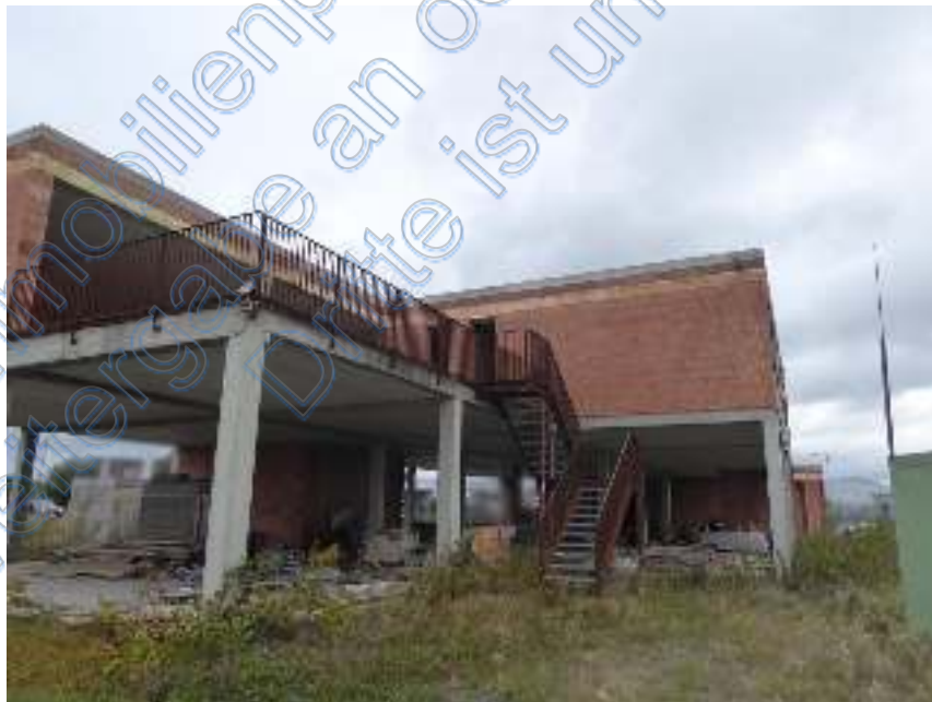
Ansicht des Bewertungsobjekts aus südlicher Richtung
