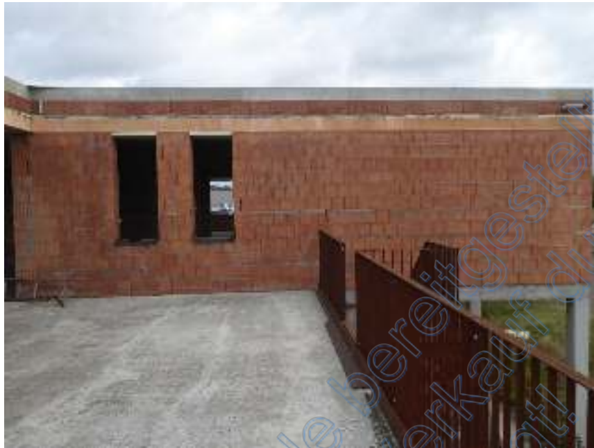
Ansicht Obergeschoss, Balkon, Galerie
