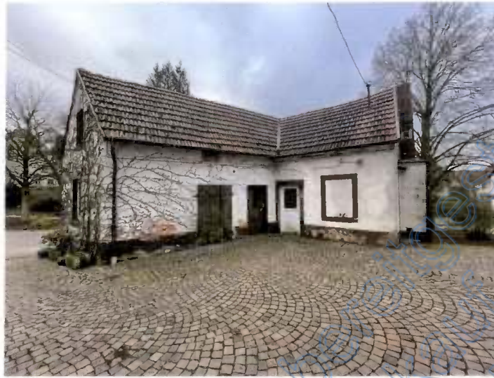
Bild 15: Hofseitige Ansicht Nebengebäude
