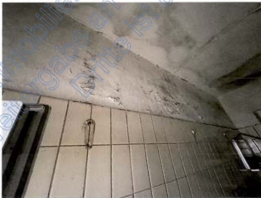
Bild 18: Feuchtigkeitsschäden Nebengebäude
