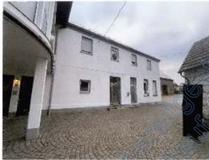
Bild 1: Hofseitige Ansicht mit Eingangsbereich
