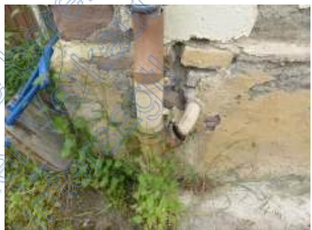
defekte Regenfallrohre
