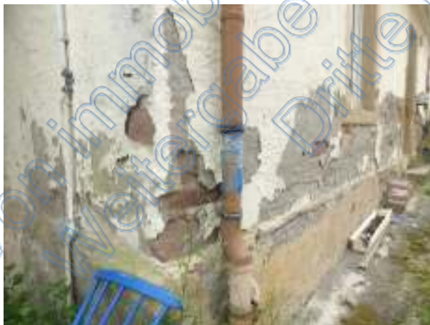
defekte Regenfallrohre
