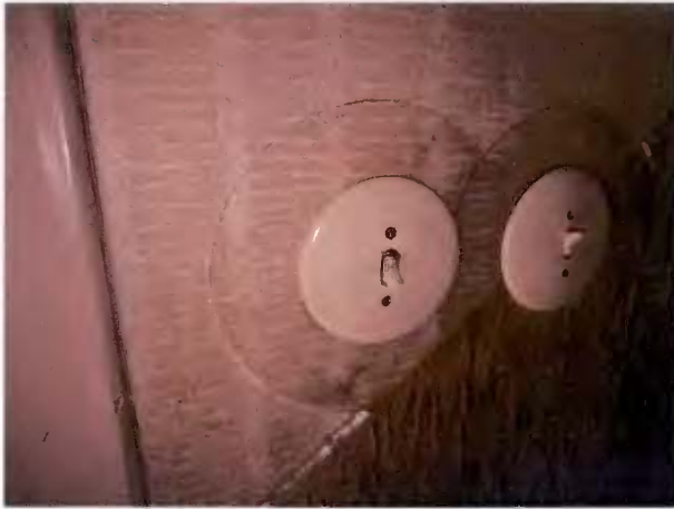
Überalterte E _ Installation
