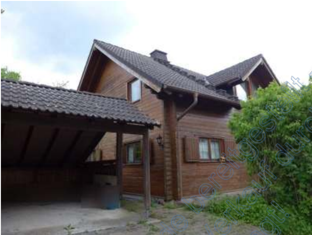
3 Nordwestansicht, Carport links im Bild
