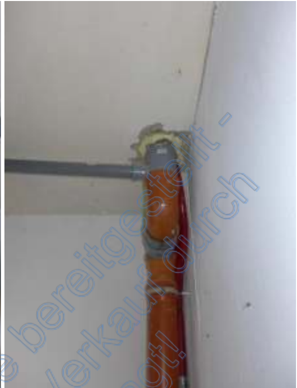
19 a+b neu gelegte Abwasserleitungen im KG nach Badumbau
