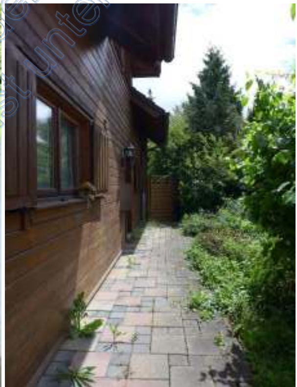
12 b Wegebefestigung Westseite
