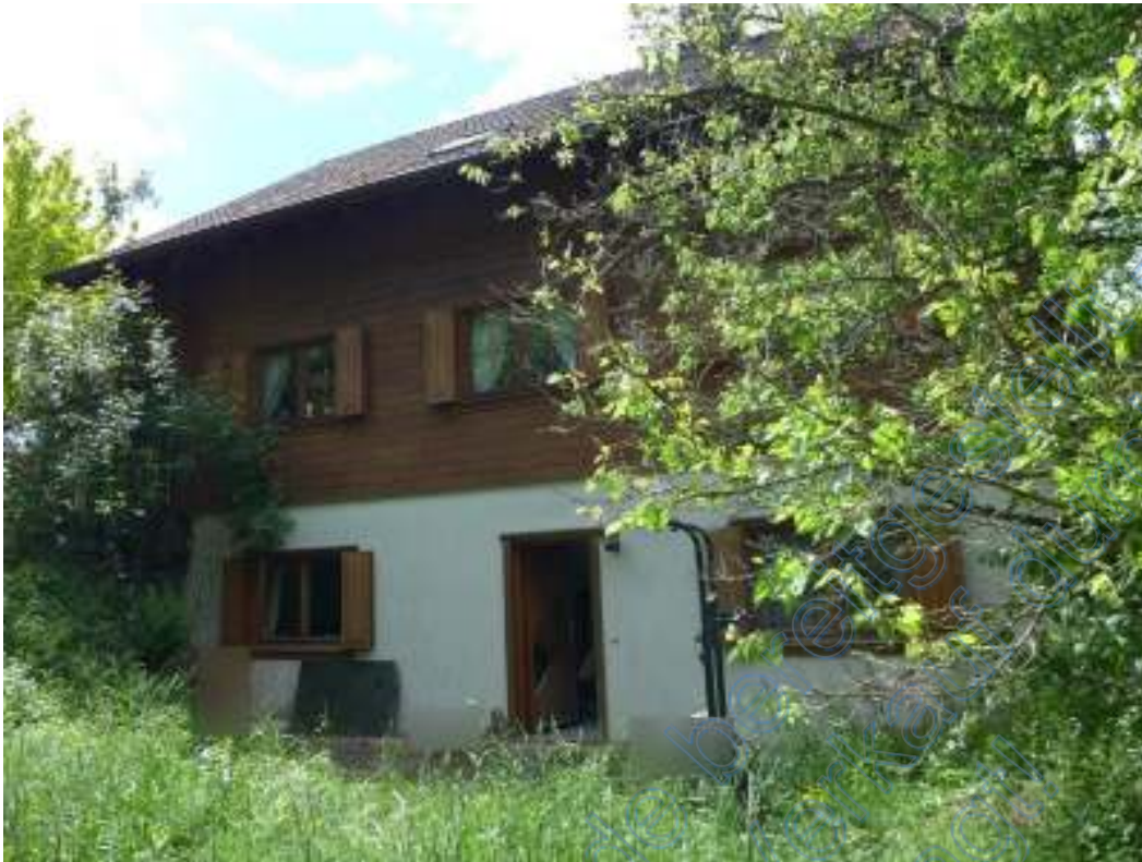
11 Nordostansicht, Gebäuderückseite, Eingang Einliegerwohnung
