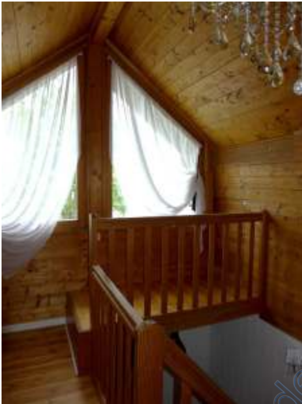
21 a Gaube im Treppenbereich DG
