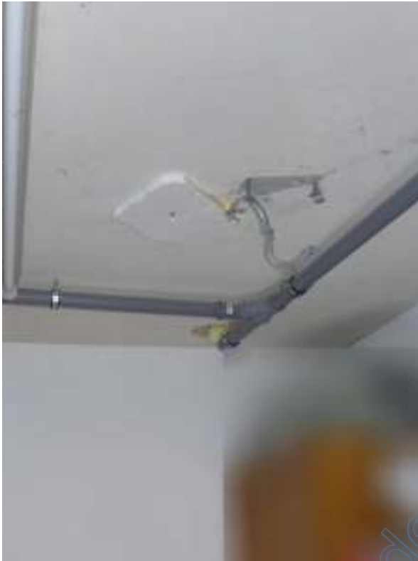
19 a+b neu gelegte Abwasserleitungen im KG nach Badumbau
