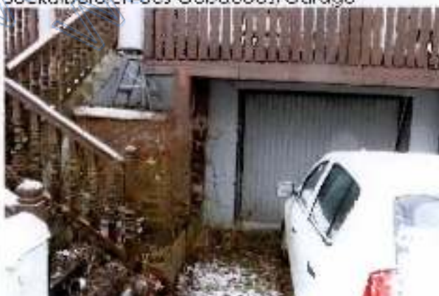
Sockelbereich des Gebäudes/Garage
