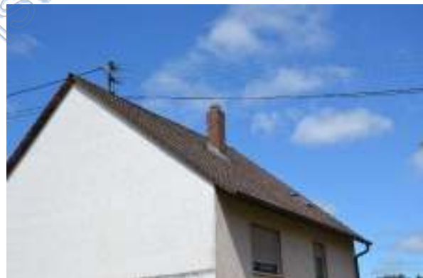
Dachansicht links mit Betonziegeln
