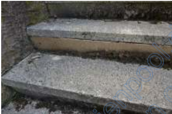
schadhafte Treppenstufen
