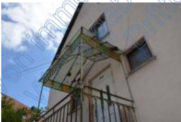
schadhafte Eingangsüberdachung
