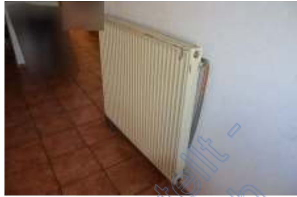
Heizkörper, Bodenbelag sowie Wandfläche exemplarisch
