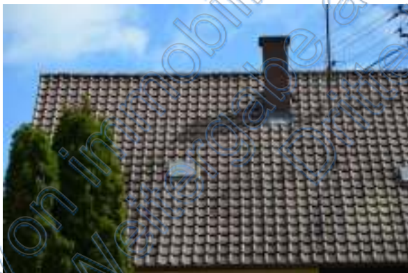
Dachansicht rechts mit Tonziegeln
