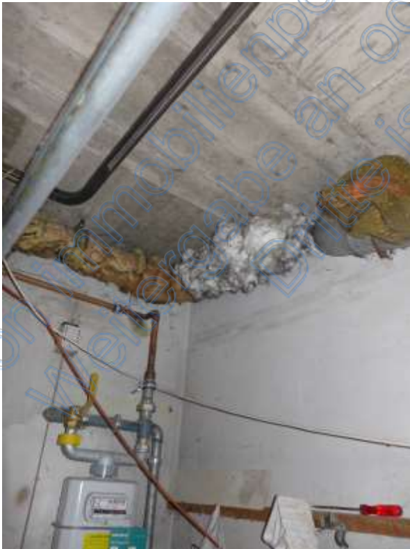
18 a Leitungen Keller, offene Dämmung
