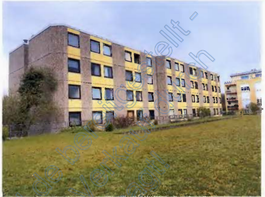
Foto 3 des SV: Wohnanlage Am Gonsenheimer Spieß 4, südlicher Gebäudeteil, Ansicht von Südwesten, von der Straße
