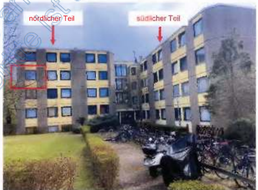
Foto 2 des SV: Wohnanlage Am Gonsenheimer Spieß 4, nördlicher und südlicher Gebäudeteil; Ansicht von Nordwesten; Detail Wohnung Nr. U 1; Roteintragung d.d. SV
