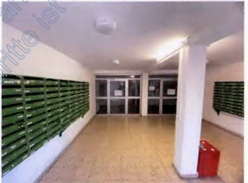
Foto 4 des SV: Wohnanlage Am Gonsenheimer Spieß 4, Erdgeschoss, Eingangsbereich
