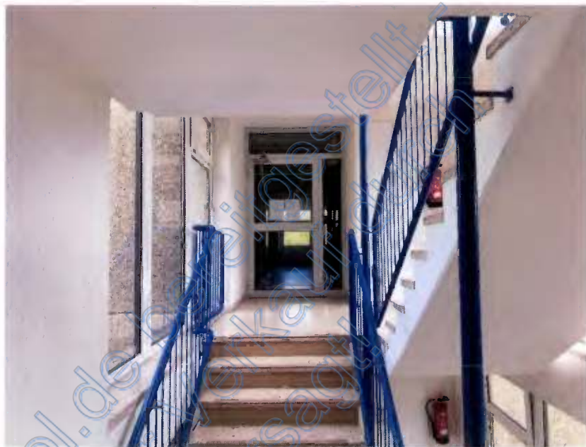
Foto 5 des SV: Wohnanlage Am Gonsenheimer Spieß 4, Treppenhaus
