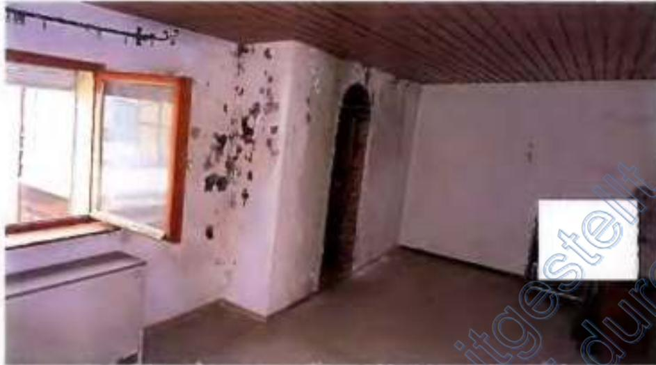
Zimmer im Anbau OG mit erheb. Feuchteschäden und erheb. Schwarzschildschimmelschäden im Wandbereich unter dem Wellasbestdach
