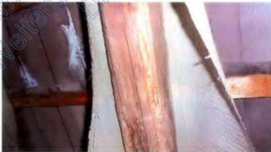
Dachbalken im DG mit Holzschädling (partiell)
