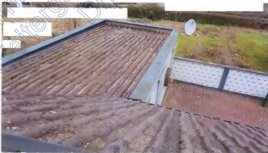
Blick auf das Dach mit Betondachziegeln und die Garage mit Welleternitplatten
