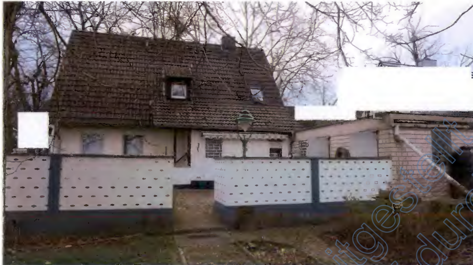
Blick zurück / Rückansicht Wohnhaus und Garage
