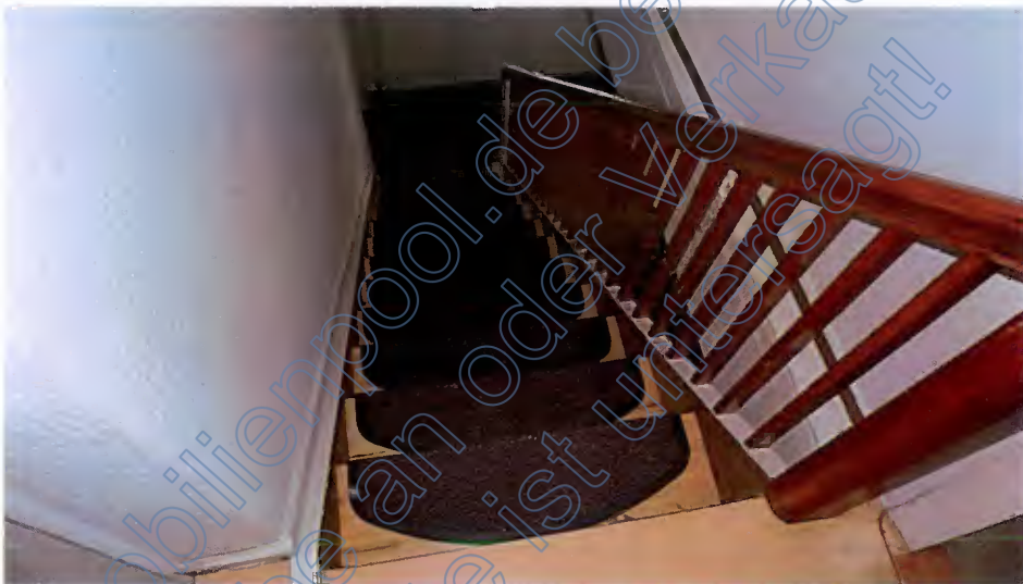
Geschosstreppe von DG aus gesehen
