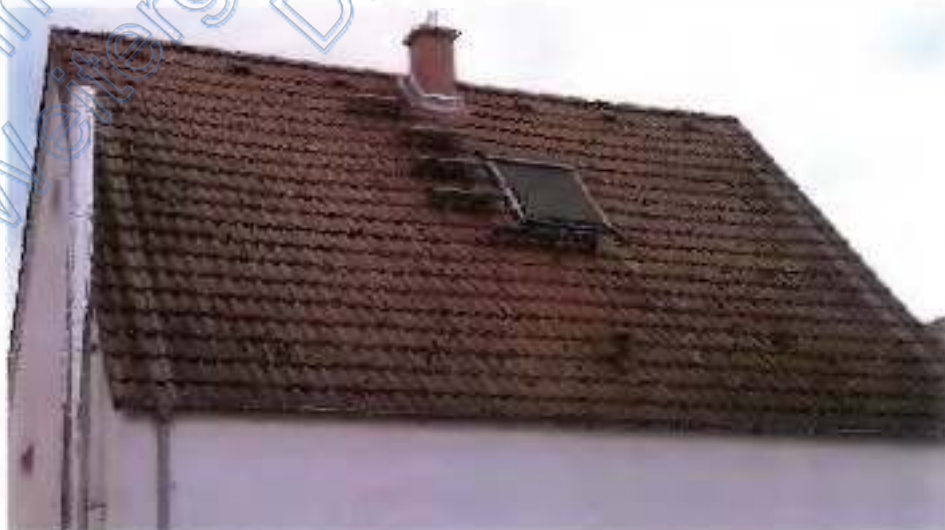
Satteldach mit Betondachziegeln
