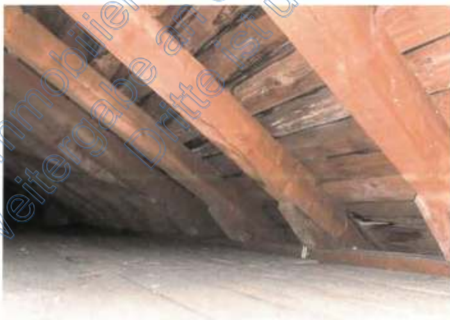
Bild 12: Blick in den Spitzboden
