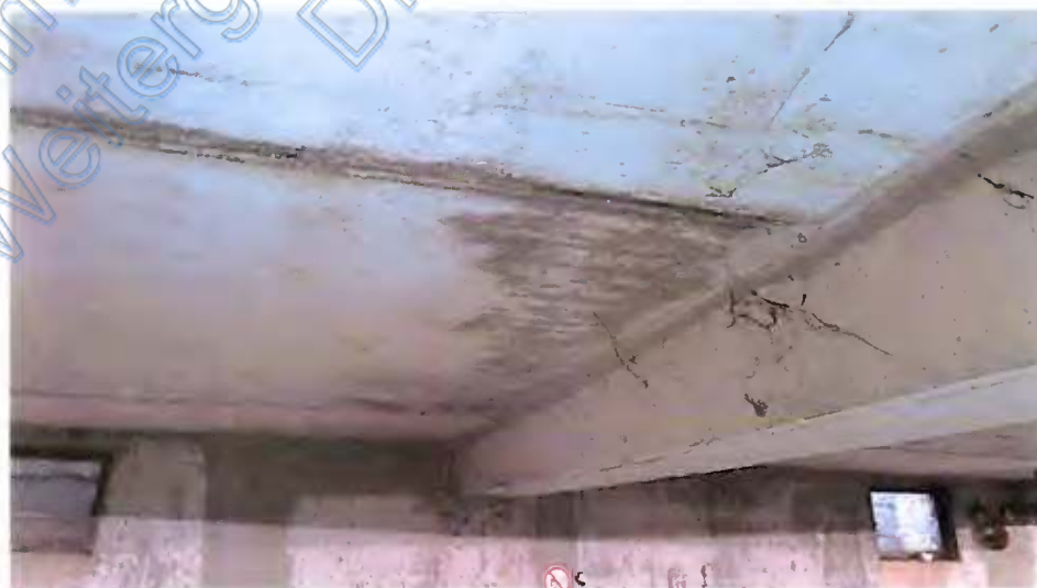
partielle feuchte Stellen an der Tiefgaragendecke
