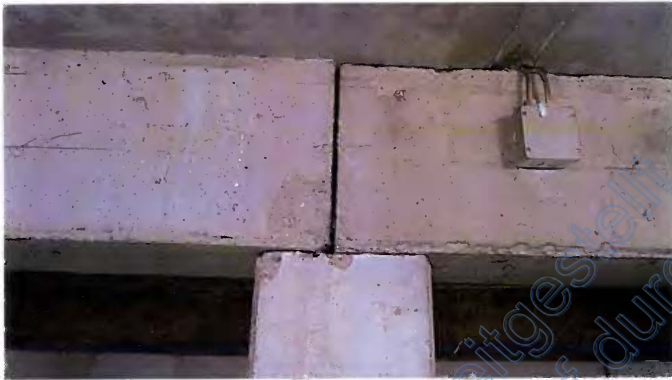
bauliche Ungenauigkeiten im Auflagerbereich Betonpfeiler in der Tiefgarage (partiell)
