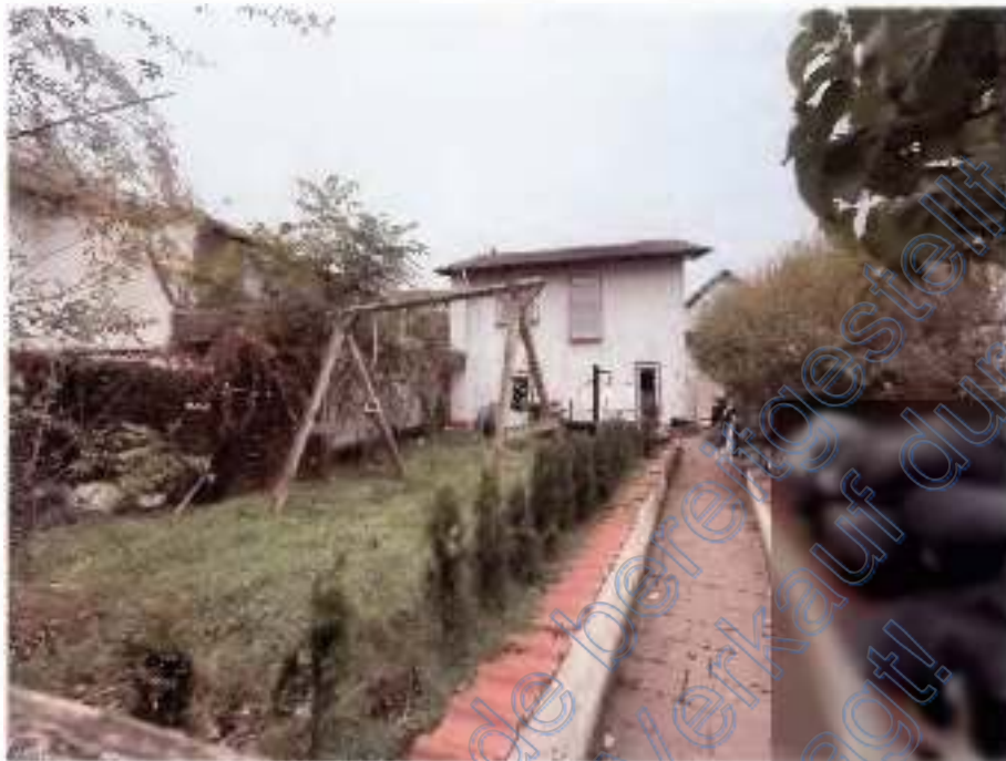
Bild 3: Blick auf das Wohnhaus 2 aus nördlicher Richtung
