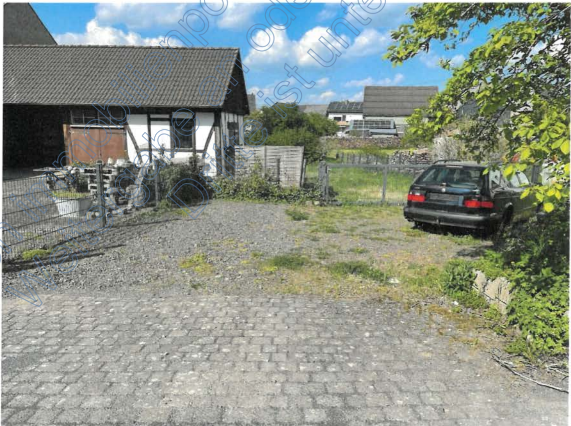
Zufahrt zu hinterem Grundstücksbereich
