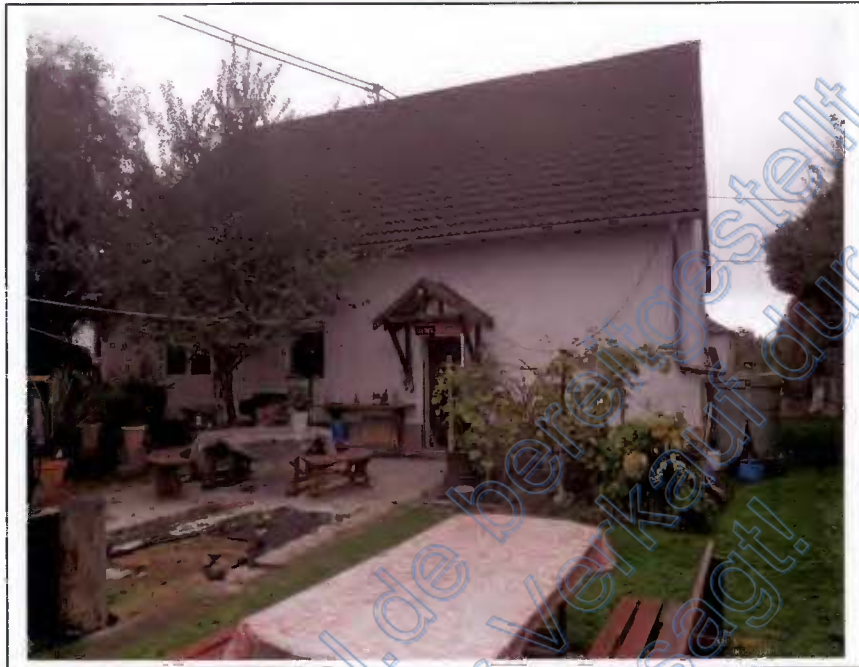
Foto 5 Garagengebäude Rückansicht (NW-Ansicht)
