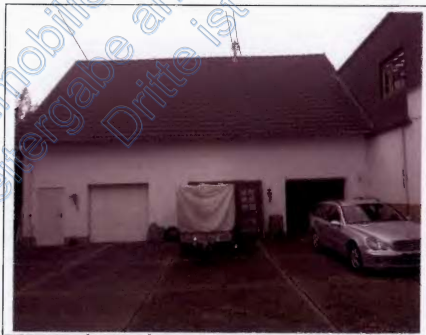
Foto 4 | Garagengebäude Straßenansicht (SO-Ansicht)
