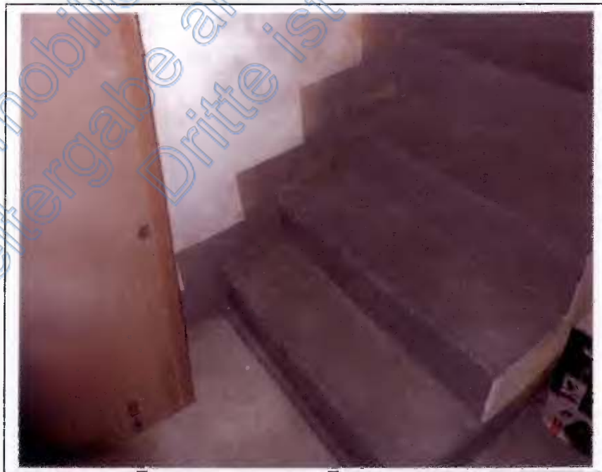
Foto 10 WHS KG/EG Betontreppe
