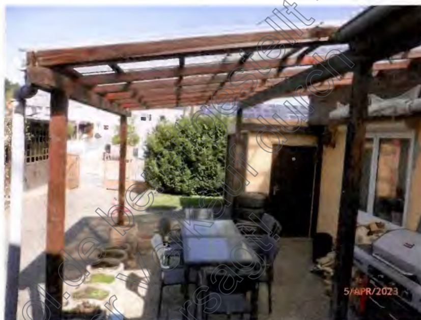
Terrasse mit Überdachung
