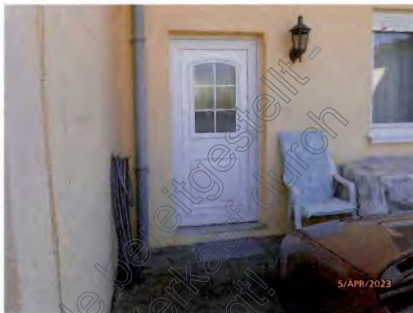
Hauseingang Einliegerwohnung im Anbau
