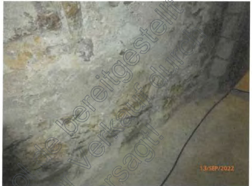
Innenansicht Kellergeschoss, Wandfeuchte
