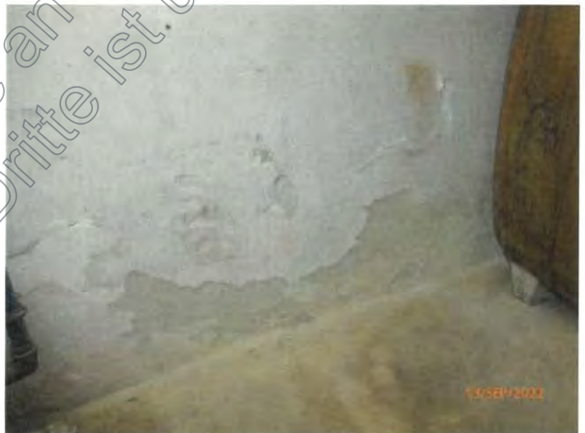
Innenansicht Kellergeschoss, Wandfeuchte
