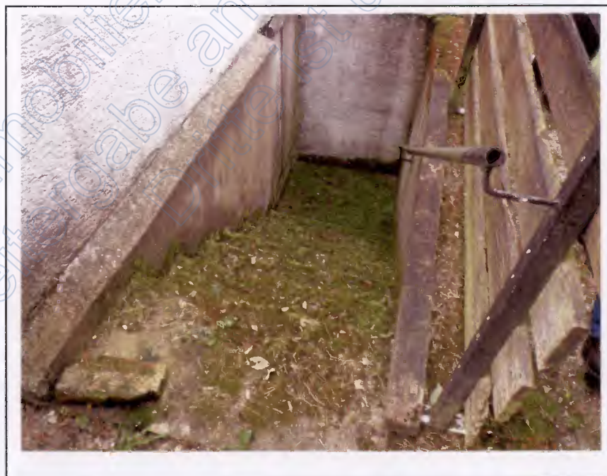
Foto 8 Wohnhaus Nr. 7 Giebel (NO-Ansicht) KG-Außentreppe zum Teilkeller
