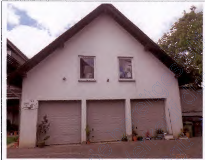
Foto 3 Dreifachgarage zu Nr. 5 (SO-Ansicht)
