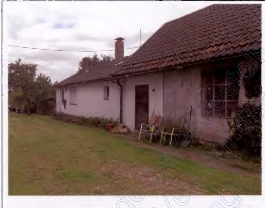
Foto 5 Wohnhaus Nr. 7 (NW-Ansicht) Hauseingang
