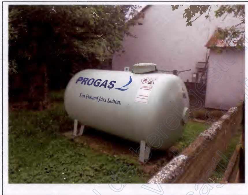
Foto 7 Wohnhaus Nr. 7 Giebel (NO-Ansicht) Gastank für Heizung
