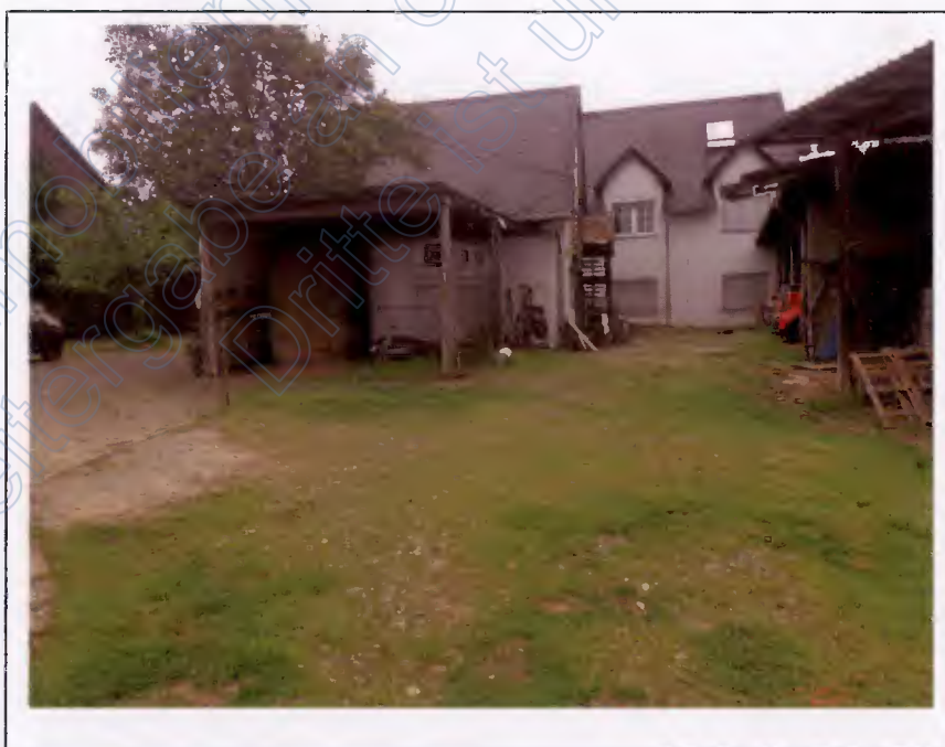
Foto 4 Dreifachgarage zu Nr. 5 (SO-Ansicht) Rückseite mit Außentreppe zum DG
