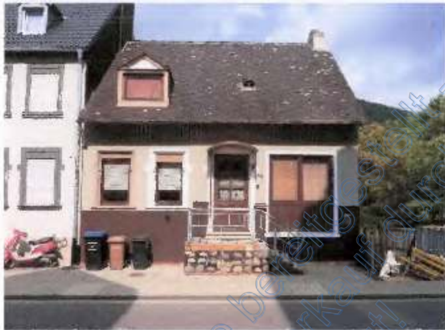
Straßenansicht Obersteiner Straße
