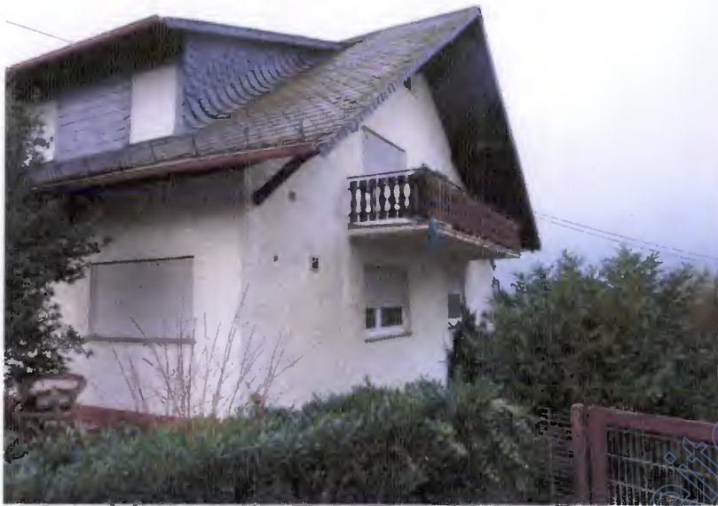
Hausfassade von Osten
