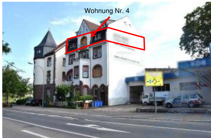
Ansicht aus Süden
