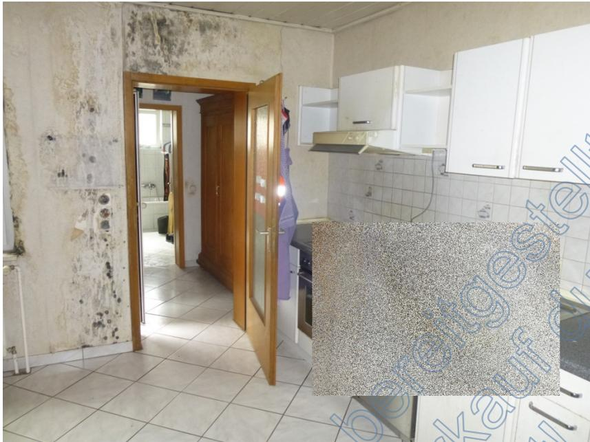
Bild 5: Küche (Feuchtigkeitsschäden) und Eingangshalle
