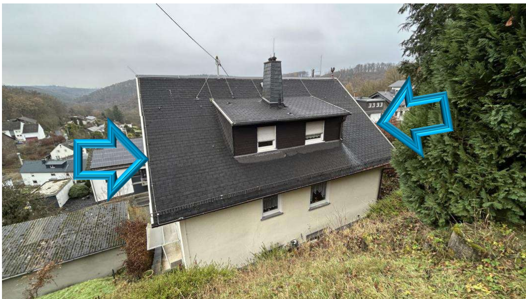
Bild B5 Gebäuderückseite
