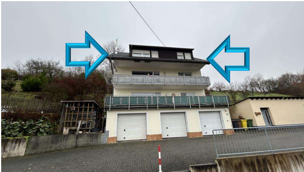
Bild B2 Straßenansicht
