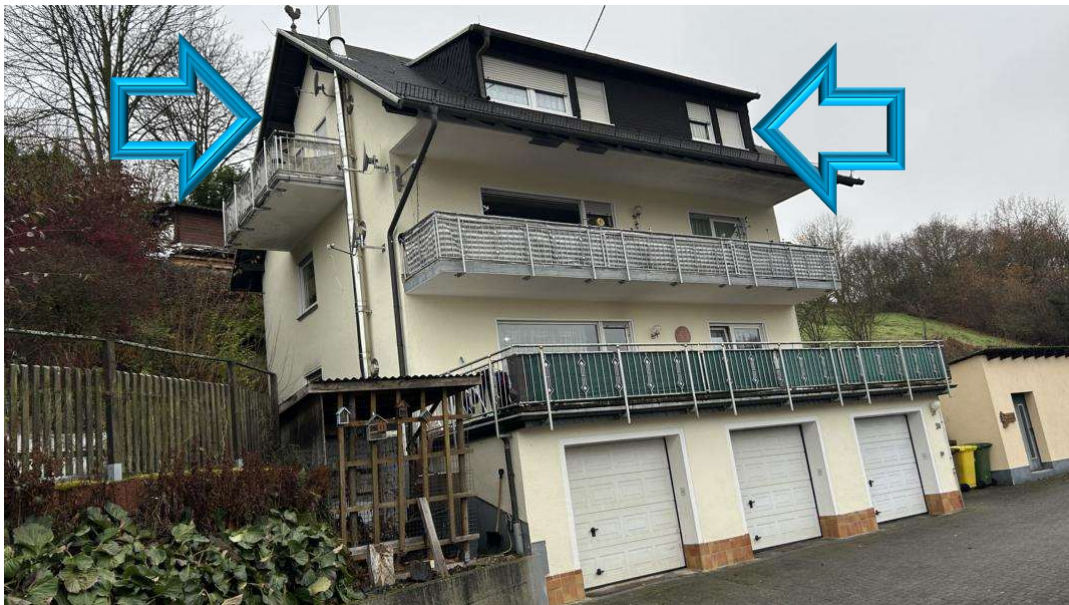
Bild B1 Straßenansicht
