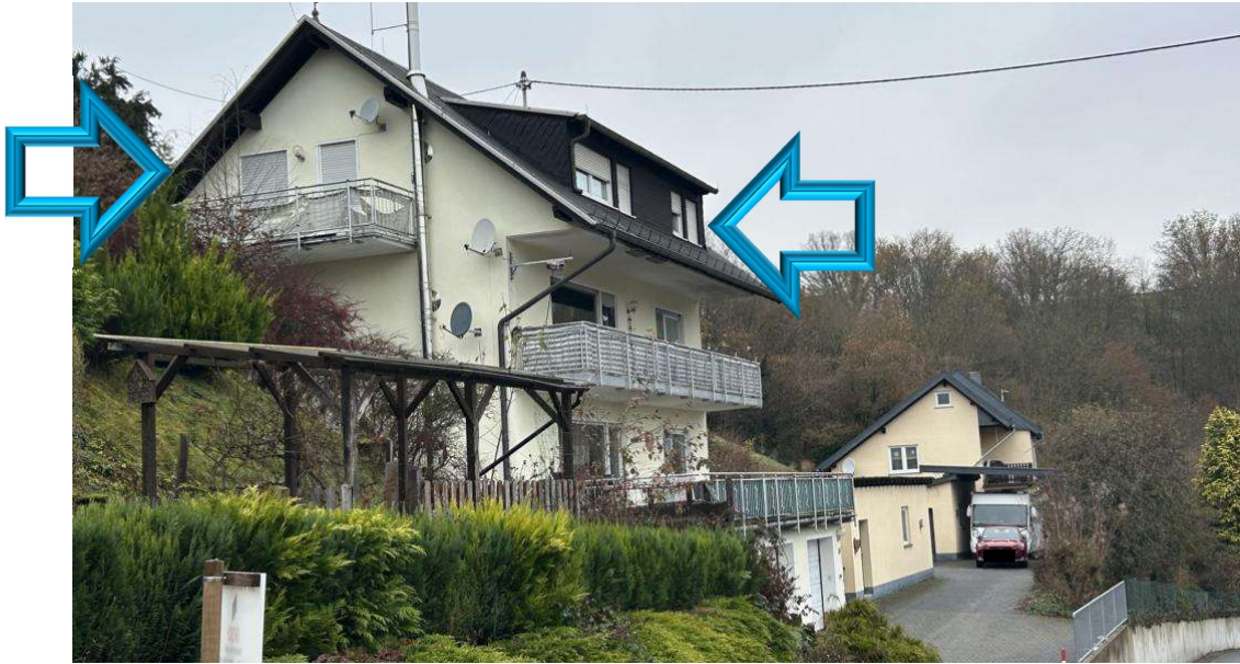
Bild B4 Straßenansicht
