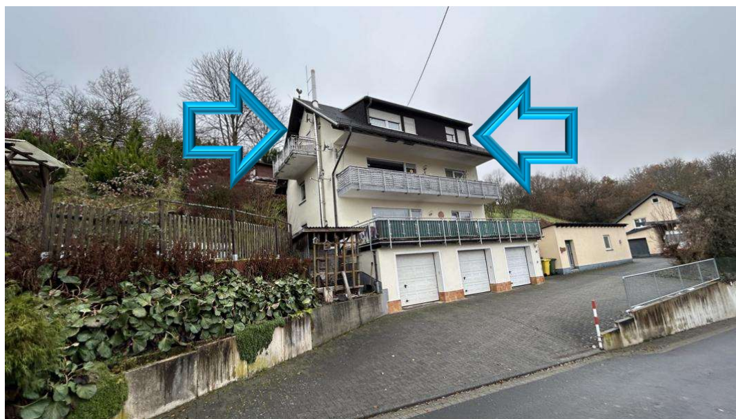
Bild B3 Straßenansicht
