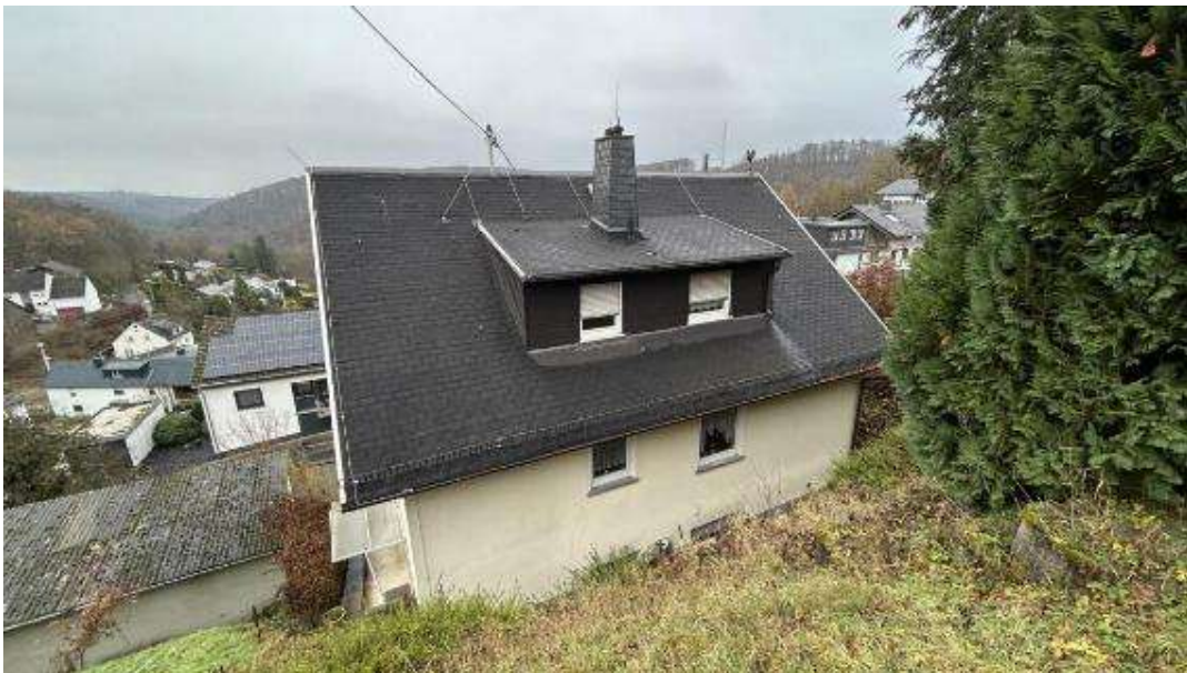
Bild B5 Gebäuderückseite
