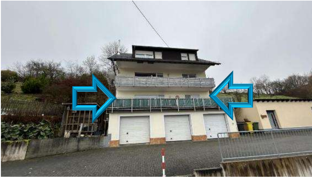
Bild B2 Straßenansicht
