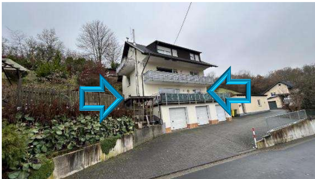
Bild B3 Straßenansicht
