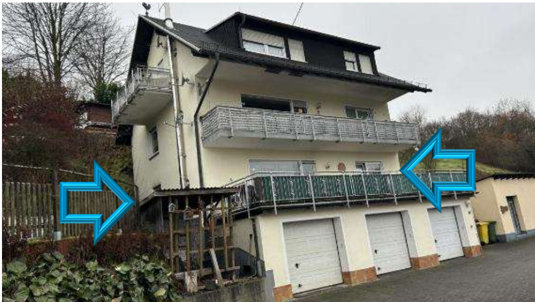
Bild B1 Straßenansicht
