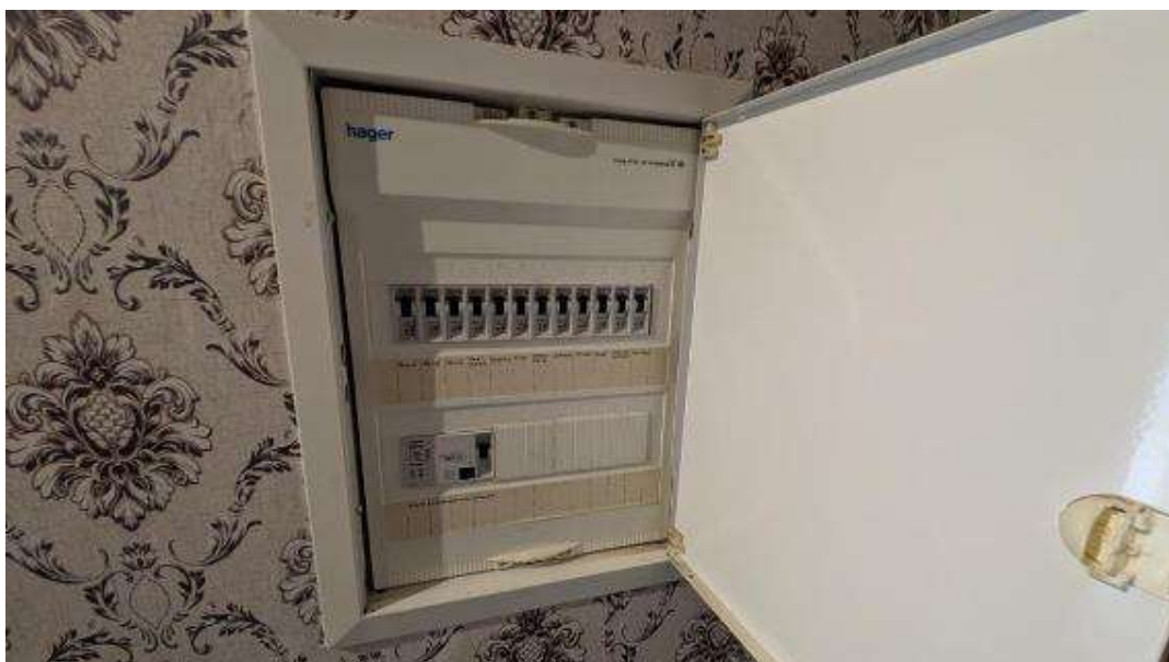
Bild C1 Beispiel Haustechnik Mehrfamilienhaus
