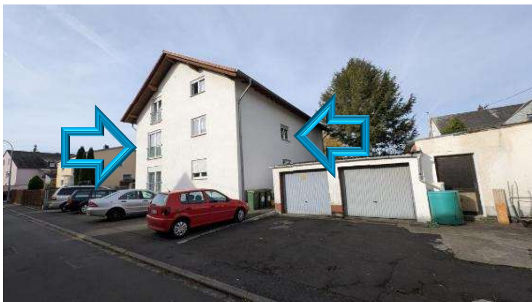
Bild B3 exemplarische Ansicht Mehrfamilienhaus
