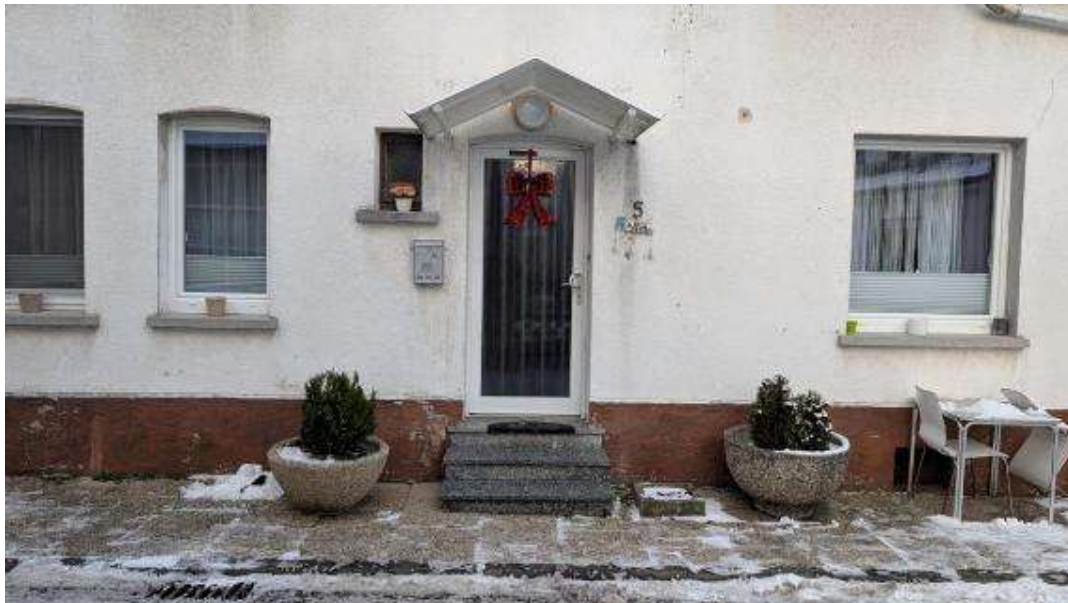
Bild B12 Eingangsbereich Wohnhaus
