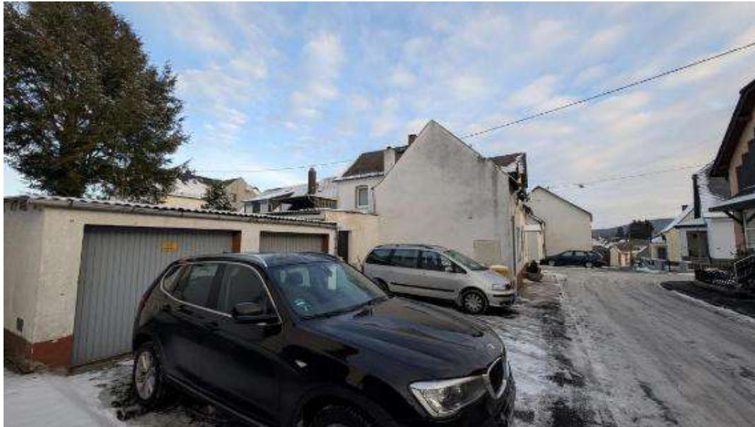
Bild B10 exemplarische Ansicht Garage
