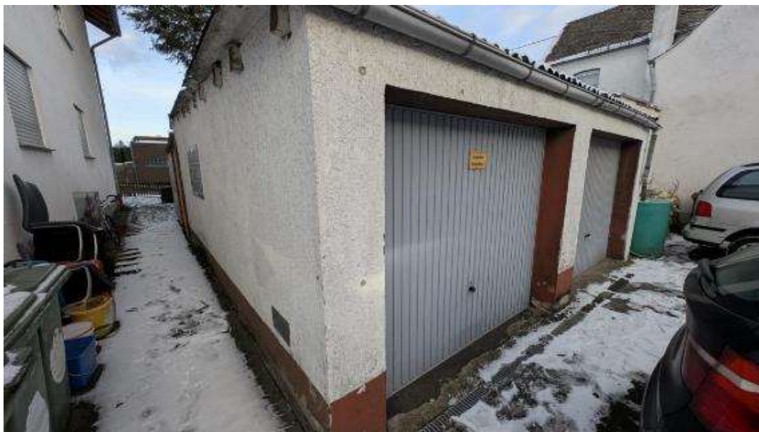
Bild B9 exemplarische Ansicht Garage
