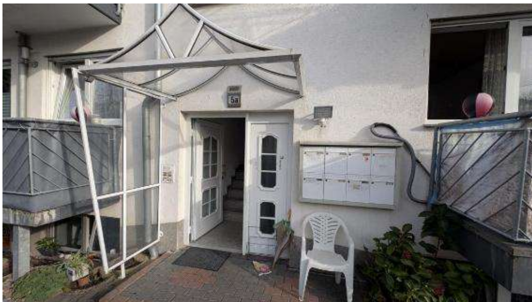
Bild B11 Eingangsbereich Mehrfamilienhaus
